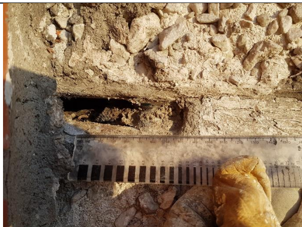
4.1.7.att. Virspusē cementa javas kārtā 15 mm, tad mastikas kārtā 5 mm un apaļveida blīvējums d30. Mastikas un cementa javas kārtas adhēzija pie paneļa sānu malu virsmas ir vāja.
