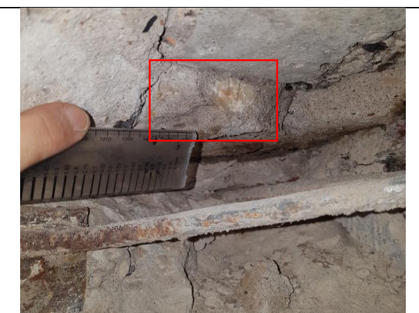
3.1.4.att. Atsegums A5. Monolitizētā paneļu savienojuma cementa javas aizpildījuma karbonizētais slānis lielāks par 3 cm.
