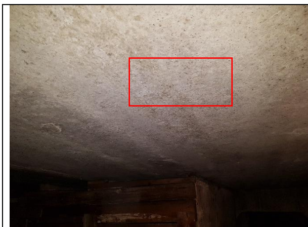
2.1.13.att. Ēka Salacas ielā 17, pagraba pārsegums
