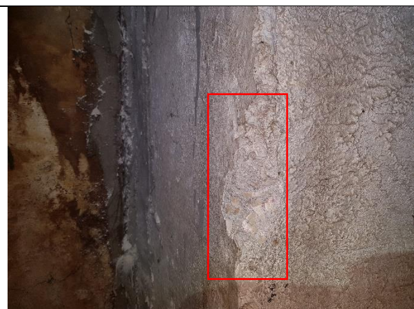
3.1.1.att. Pagraba nesošās dzelzsbetona sienas. Karbonizētais slānis lielāks par 1,0 cm.
