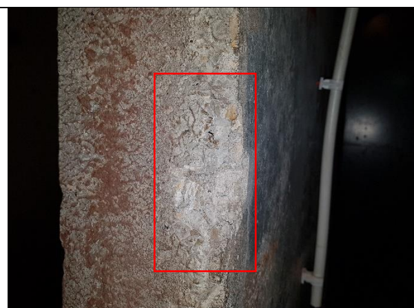
3.1.3.att. Pagraba nesošās dzelzsbetona sienas. Karbonizētais slānis lielāks par 1,0 cm.
