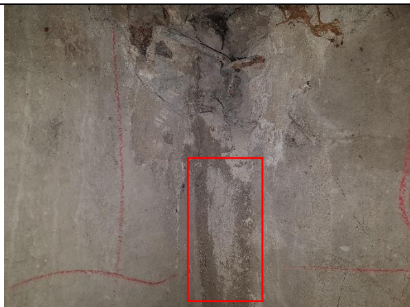
2.1.19.att. Ēka Salacas ielā 17, ārsienu monolitizētās šuves betona virsma, pie atseguma A6
