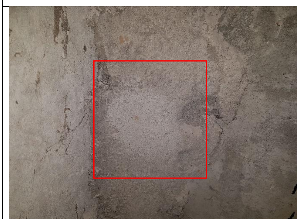
2.1.15.att. Ēka Salacas ielā 17, ārsienu monolitizētās šuves betona virsma, pie atseguma A2
