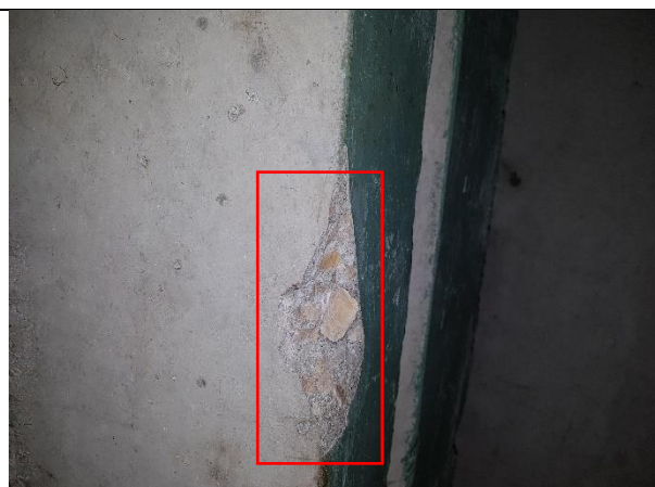
3.1.2.att. Pagraba nesošās dzelzsbetona sienas. Karbonizētais slānis lielāks par 1,0 cm.
