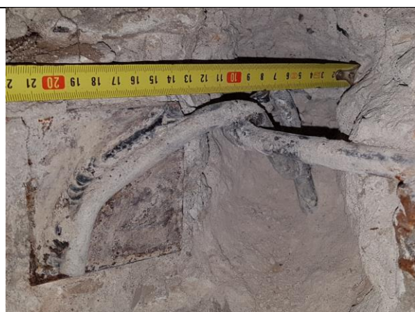
1.6.3.att. Metinājuma šuves katete 6 mm, stiprinājums piemetināts tikai no vienas puses. Cilpveida izlaidumi un savienojošās skavas gludās, ar diametru 12 mm, kas ir atbilstoši Projektā paredzētajam d12 Al.
