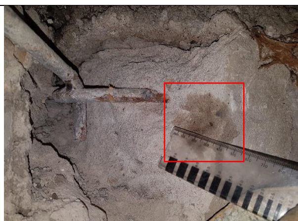
3.1.4.att. Atsegums A5. Monolitizētā paneļu savienojuma cementa javas aizpildījuma karbonizētais slānis lielāks par 3 cm.
