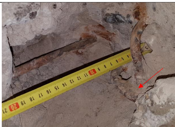
1.7.3.att. Cilpveida izlaidumi un savienojošās skavas gludās, ar diametru 12 mm, kas ir atbilstoši Projektā paredzētajam d12 A1.
