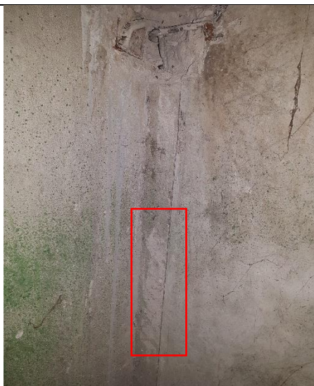
2.1.21.att. Ēka Salacas ielā 17, ārsienu monolitizētās šuves betona virsma, pie atseguma A7
