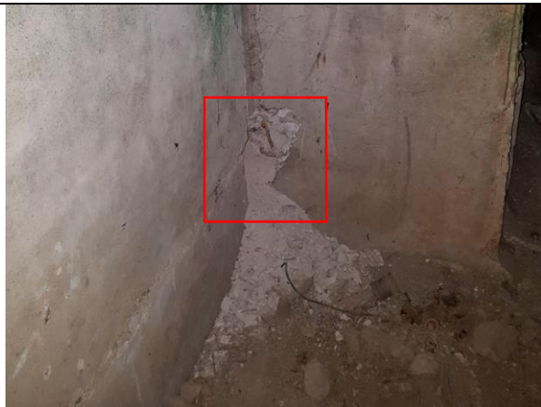
1.7.1.att. Atsegums A7 pagraba stāva atzīmē -2,15 m (pagraba grīdas līmenis -2,5 m).
