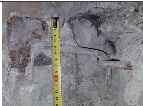
1.5.3.att. Ieliekamā detaļa 8 mm bieza, stiprinājums piemetināts tikai no vienas puses. Metinājuma šuves katete 6 mm. Cilpveida izlaidumi un savienojošās skavas gludās, ar diametru 12 mm, kas ir atbilstoši Projektā paredzētajam d12 A1.
