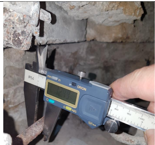
1.1.8.att. Ārsienu paneļu (markas HC24; HC30, ЦНС2; ЦНС6) cilpveida izlaidumu detaļas
