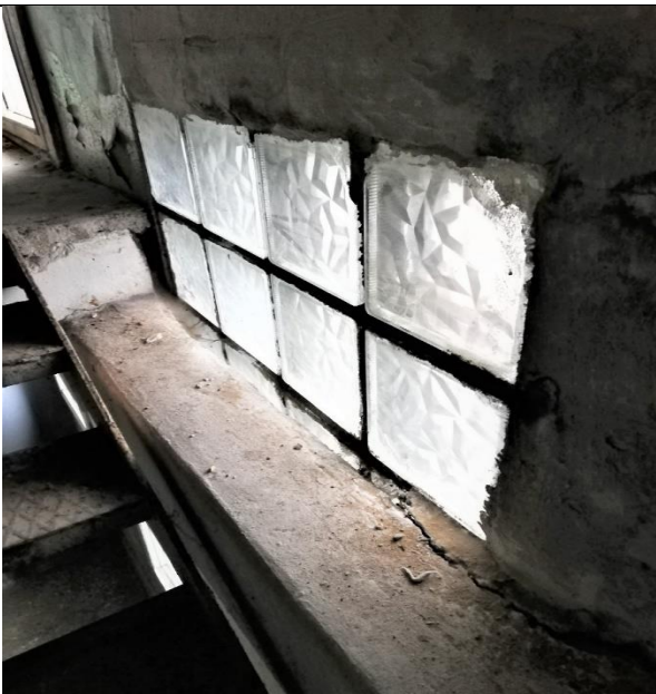
4.13.18. att. Stikla bloku ailu aizpildījums kāpņu telpas 9.stāvā.
