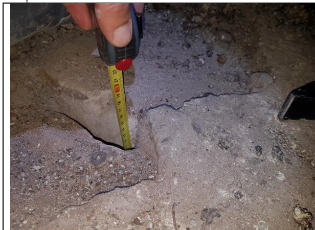
4.5.12.att. Gāzbetona plātņu siltumizolācija bēniņos, 150 mm. Edžiņa gatve 1, Rīga.
