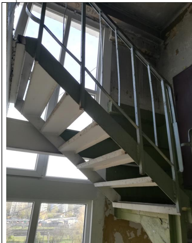
4.10.9.att. Metāla kāpnes, nokļūšanai bēniņu telpai, mašīntelpai un jumtam
