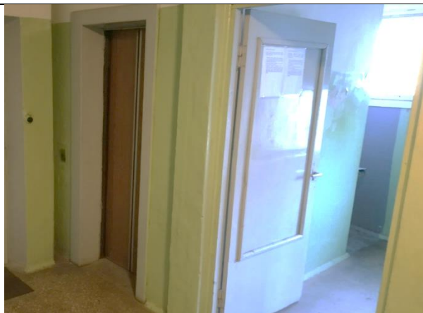
4.15.2. attēls. Lifta šahtas nesošā siena
