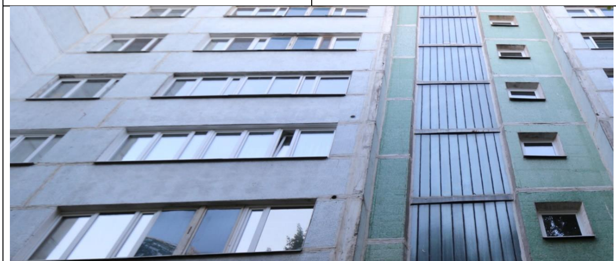
4.13.23. attēls. Stemolīta ailas aizpildījuma vietā uzstādīti PVC logi. Vīlpa iela 8, Rīga.
