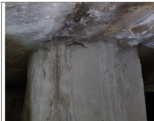
4.16.1. attēls. Vēdināšanas bloks bēniņu telpā
