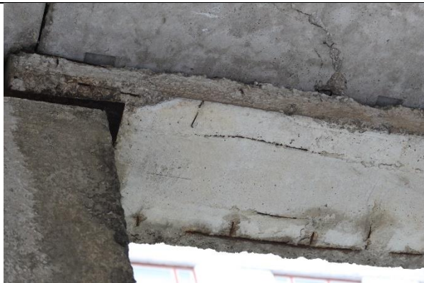
4.3.7.att. Sijas apakšējā plaukta stiegrojuma aizsargslāņa izdrupumi un stiegrojuma atsegumi
