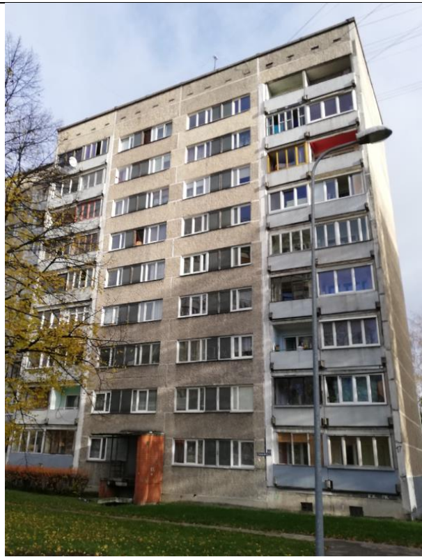
3.9. att. 467A sērijas Projekta pirmais variants, ārsienu paneļi ar šķembu apdari, 1975.gads. Salacas iela 17, Rīga.
