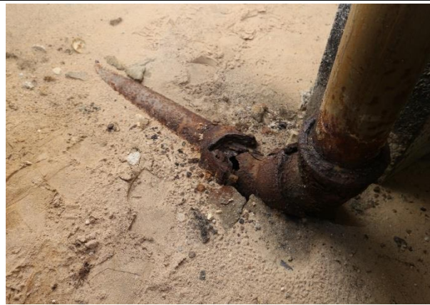
4.8.26. attēls. Sadrupis jumta lietus ūdens novadīšanas sistēmas ķeta cauruļvads pagrabā. Salacas iela 17, Rīga.
