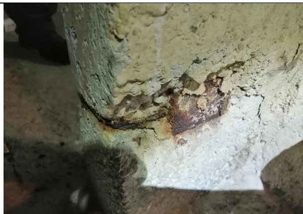
4.2.10.att. Pagraba sienas paneļa ieliekamās detaļas atsegums un korozija. Salnas iela 1, Rīga
