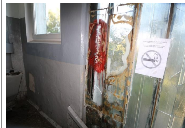
4.13.21. attēls. Stikla profilītu bojājums kāpņu telpā, remonta pazīmes. Vīlpa iela 8, 1.sekcija, 3.stāvs.
