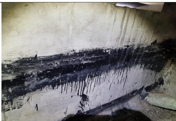
4.5.6. attēls. Bēniņu telpā šuves apstrādātas ar hidroizolējošu pārklājumu
