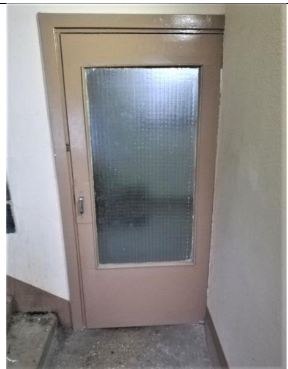
4.13.3.att. Kāpņu telpas durvis ar armēto stiklu.
