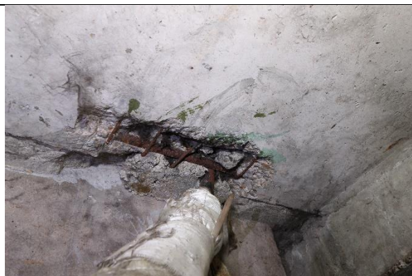
4.6.6.att. Inženiersistēmu šķērsojuma vieta pagrabā - atsegts un korodējis tērauda stieģrojums. Dzērvju iela 10, Rīga.
