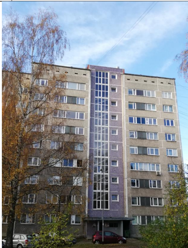
3.8. att. 467A sērijas Projekta pirmais variants, ārsienu paneļi ar šķembu apdari, 1975.gads. Stikla profilīti nomainīti uz PVC logu konstrukcijām. Salacas iela 17, Rīga.
