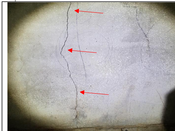
4.4.8. attēls. Plaisa fasādes cokola panelī (marka ЦHC) ar atvērumu 3-4 mm. Vīlipa iela 8, Rīga.
