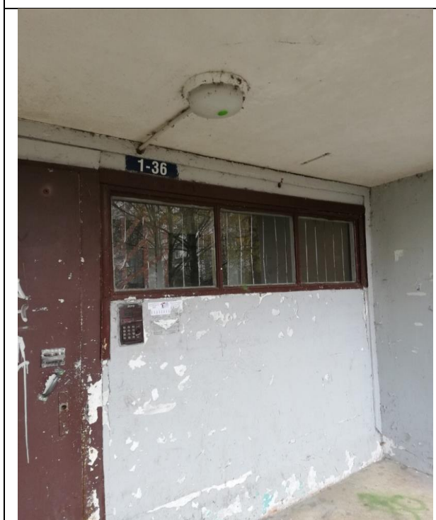
4.13.5. attēls. Ieejas mezgla metāla durvis ar korozijas bojājumiem
