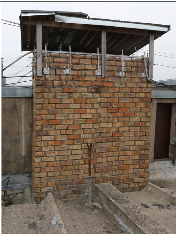
4.16.6. attēls. Vēdināšanas šahta uz jumta
