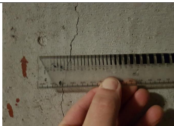
4.2.8. attēls. Nebūtiska plaisa nesošās sienas panelī ЭП2, atvērums 0,5 mm (pagraba telpas)
