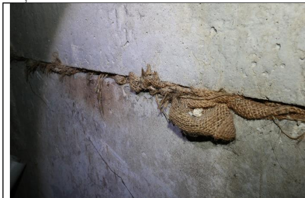
4.5.3.att. Saduršuve tehniskajā stāvā vietām aizpildīta ar maisaudumu.
