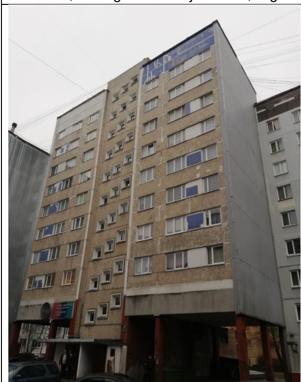
3.12. att. Karkasa-paneļu ēka, ar piebūvēto būvapjomu, 1985.gads. Jasmuižas iela 12, Rīga.
