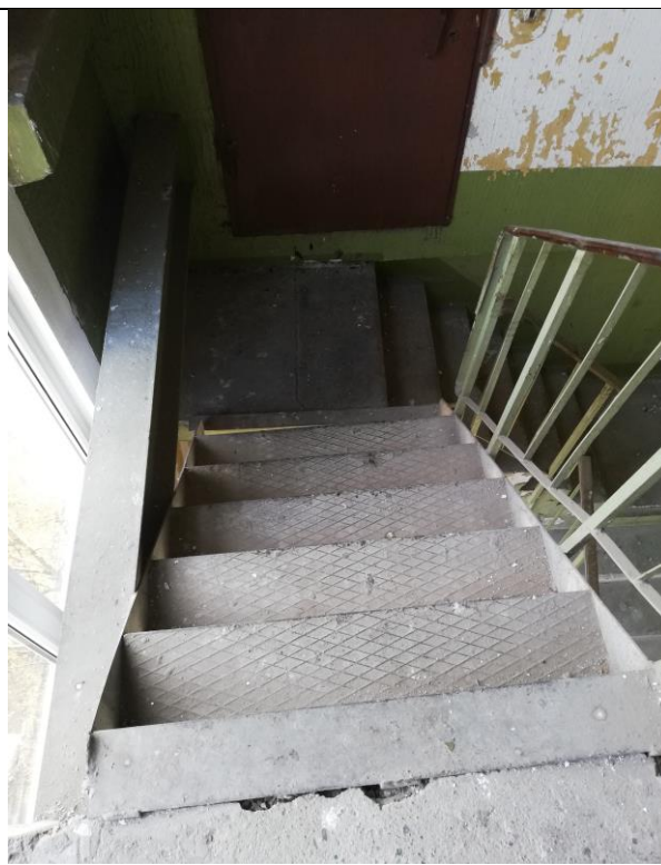
4.10.10.att. Metāla kāpnes, nokļūšanai bēniņu telpai, mašīntelpai un jumtam
