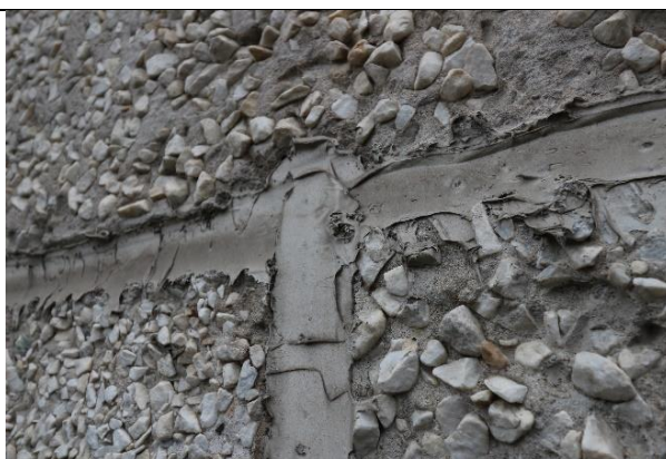
4.5.8. attēls. Ar mastiku lokāli atjaunota saduršuves vieta.
