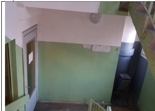
4.15.1. attēls. Lifta šahtas nesošā siena
