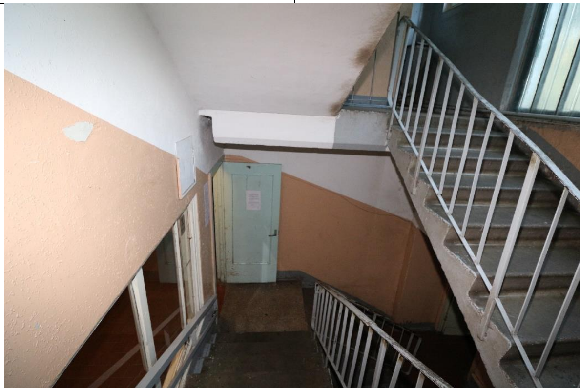
4.10.8.att. Dzelzsbetona gatavelementu kāpņu laidumi. Margas bez vinila nosegelementiem.
