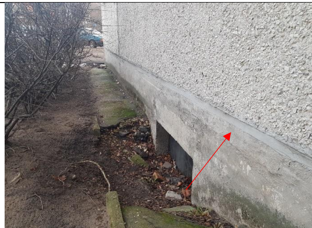
4.1.4. attēls. Hidroizolācija uz atz. -0,69 m.
