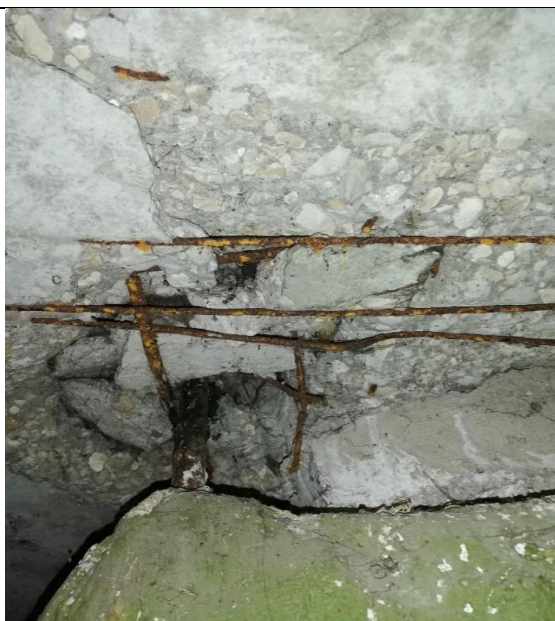
4.6.5.att. PAGRABA Telpā pāseguma plātnē plaisa (1,5 mm plata), kas neietekmē nestspēju. Ēka Dzērvju ielā 10, Rīga.
