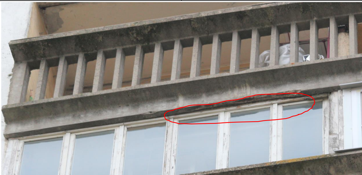
4.9.10.att. Bojājumi lodžijas norobežojošā elementa apakšējā joslā. Dzērvju iela 10, Rīga.
