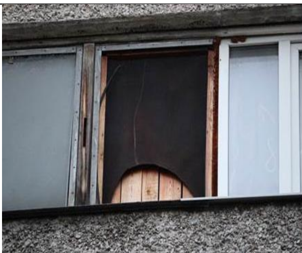
4.13.27. attēls. Ar stemolītu nosegtas ailas, bojāta stemolīta apdare. Salacas iela 17, Rīga.
