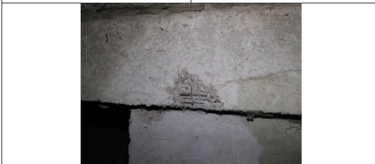
4.8.13.att. Teknes virsmā izdrupums un atsegts nesošais stiegrojums. Salacas iela 17, Rīga.
