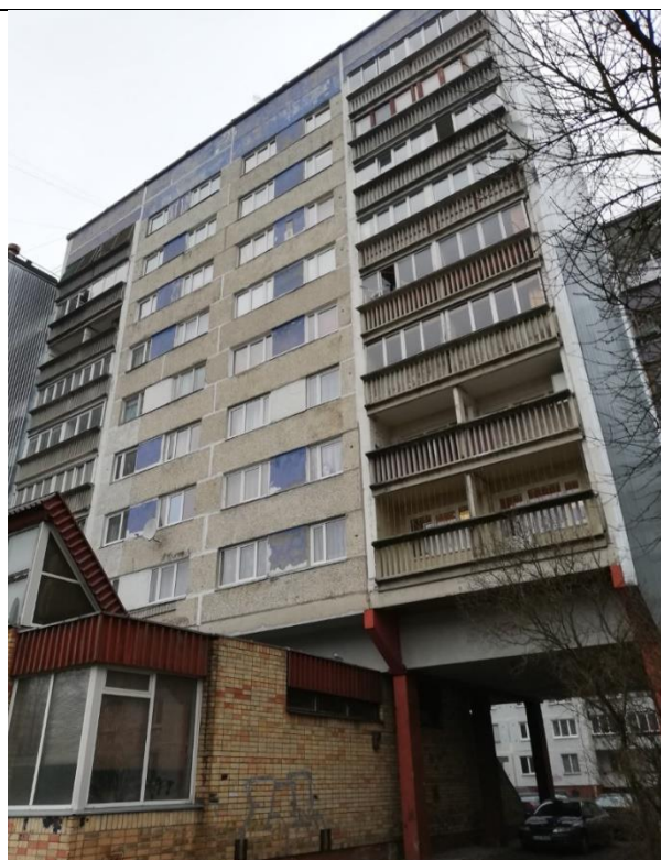
3.13. att. Karkasa-paneļu ēka, ar piebūvēto būvapjomu, 1985.gads. Jasmuižas iela 12, Rīga.
