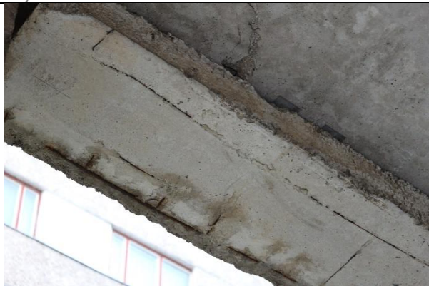
4.3.6.att. Sijas apakšējā plaukta stiegrojuma aizsargslāņa izdrupumi un stiegrojuma atsegumi
