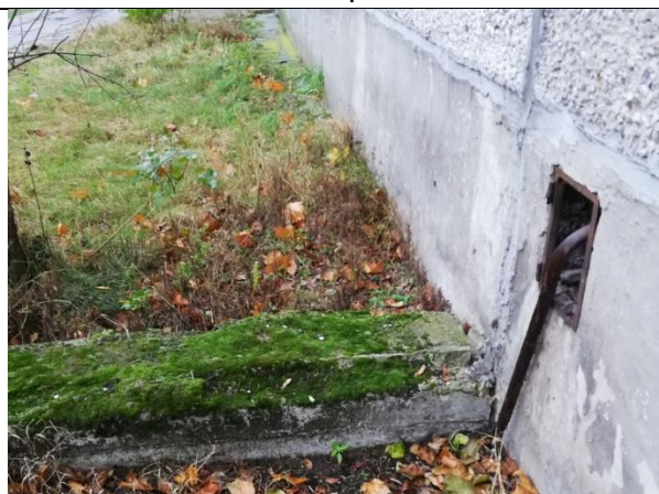
4.1.8. attēls. Ēkas aizsargapmale ar apaugumu
