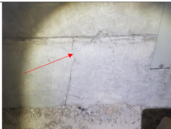
4.4.11. attēls. Vertikāla plaisa ārsienas panelī (marka HC) ar atvērumu 0.7 mm,
