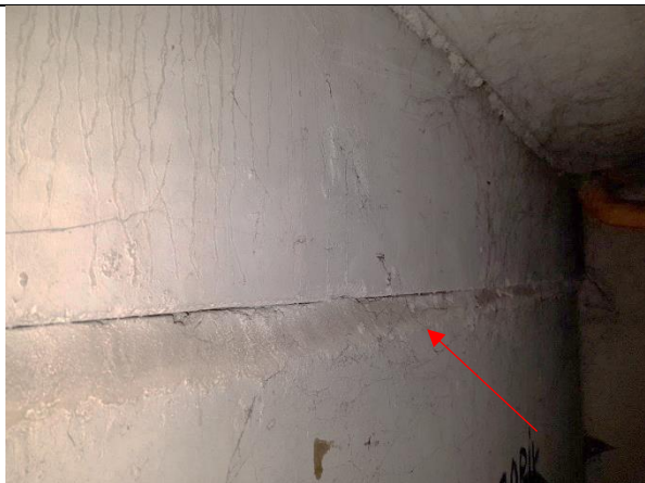
4.1.3. attēls. Hidroizolācija uz atz. -0,69 m.
