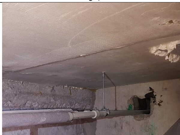
4.5.15.att. Tehniskā stāva pārseguma siltumizolācija no putupolistirola loksnēm ar apmetumu uz sieta. Jasmuižas iela 12, Rīga.
