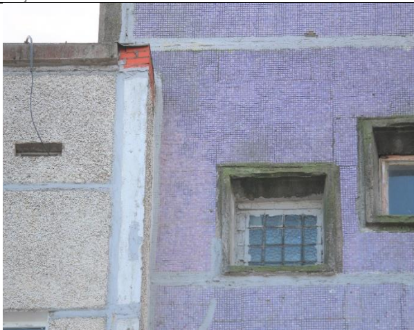
4.13.13. attēls. Stikla bloku ailas aizpildījums kāpņu telpā. Edžiņa gatve 1, Rīga.
