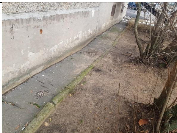
4.1.5. attēls. Ēkas aizsargapmale ar iesēdumiem un apaugumu
