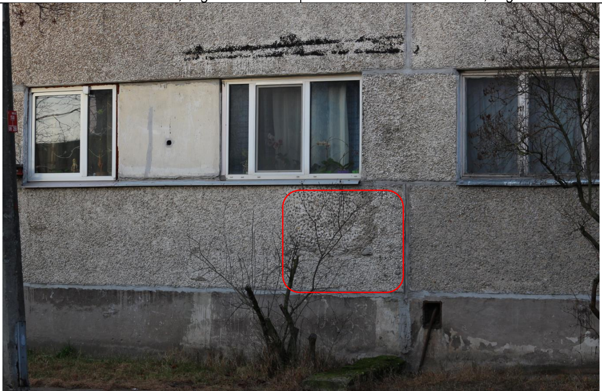
3.16. att. Rezerves ejas durvis ir aizmūrētas, iepriekš – rezerves ejas nojume ar kāpnēm. Edžiņa gatve 1, Rīga.
