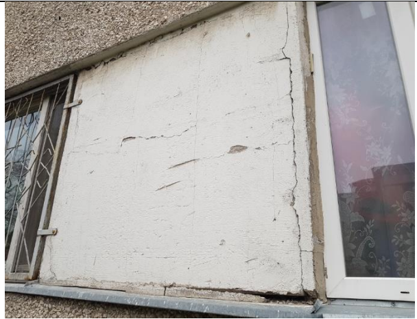
4.13.25.att. Bojāts gāzbetona panelis – plaisu tīkls, izdrupumi, malu defekti
