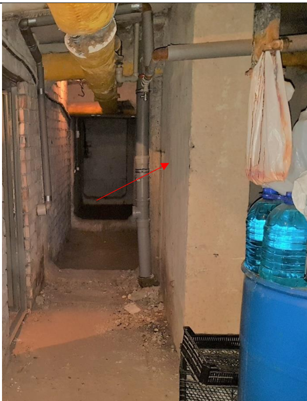
4.16.5. attēls. Vēdināšanas bloki B51 320 mm biezumā (pagraba telpa)
