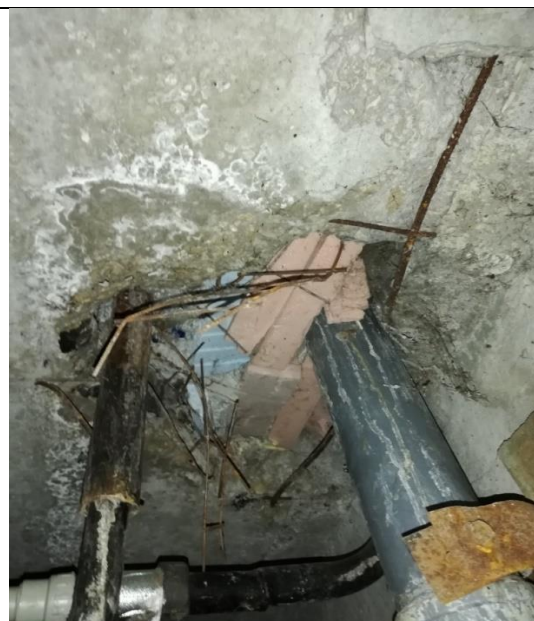
4.6.6.att. Inženiersistēmu šķērsojuma vieta pagrabā - atsegts un korodējis tērauda stieģrojums. Dzērvju iela 10, Rīga.
