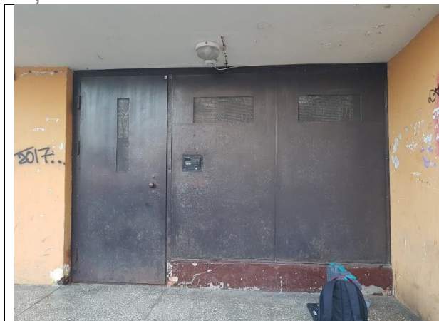
4.13.5. attēls. Ieejas mezgla metāla durvis ar korozijas bojājumiem
