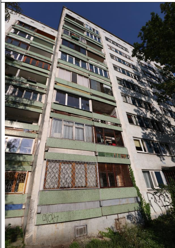
3.6. att. 467A sērijas Projekta pirmais variants, ārsienu paneļi ar stikla mozaīkas apdari, 1973. būvniecības gads. Vīlpa iela 8, Rīga.
