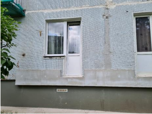
4.7.11. att. Demontētas balkonu plātnes ēkas 1.stāvā.
