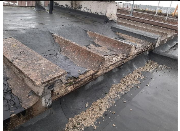
4.3.50., 4.3.51.att. Kāpņu telpas savietotā jumta siltumizolācija ierīkota daļējā apjomā.
