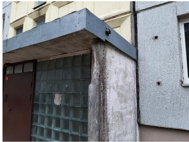
4.7.48.att. 4.7.49.att. Jumiņa dzelzsbetona plātnes betona struktūra un sienas paneļi ir bojāti mitruma un sala iedarbībā. Risinājums atbilst Projekta.
