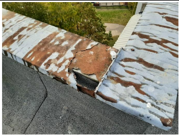
4.6.92.att. Skārda parapetu korozija, skārda bojājumi
