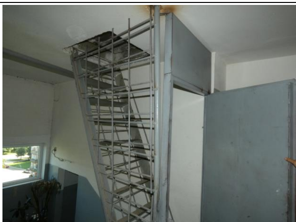
4.8.21. att. 4.8.22. att. Metāla kāpnes uz bēniņu stāvu
