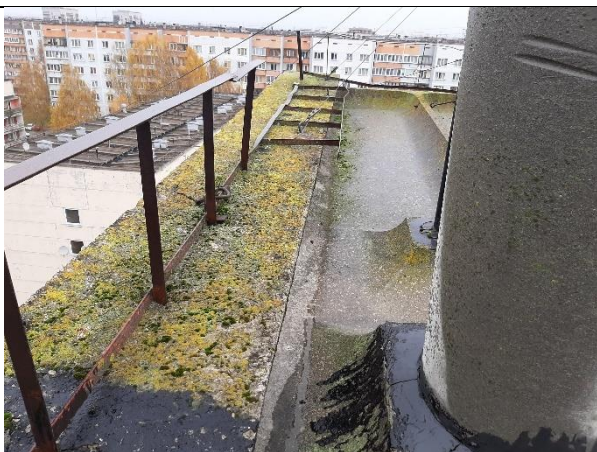
4.6.77.att. Mitruma un sala ietekmē bojāti jumta klāja elementi
