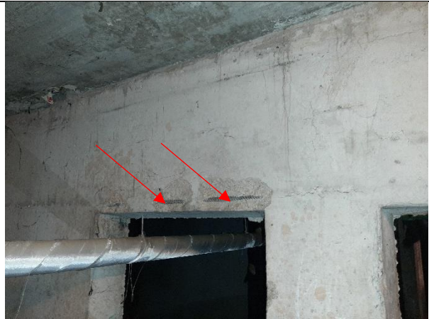
4.2.18. att. Neatbilstošs aizsargslānis, atsegts stiegrojums
