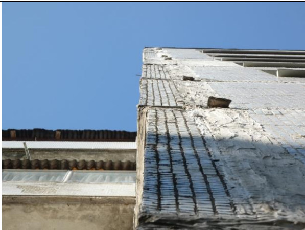
4.2.84.att., 4.2.85.att. Paneļu montāža veikta ar būtiskām novirzēm no vertikālās ass.
