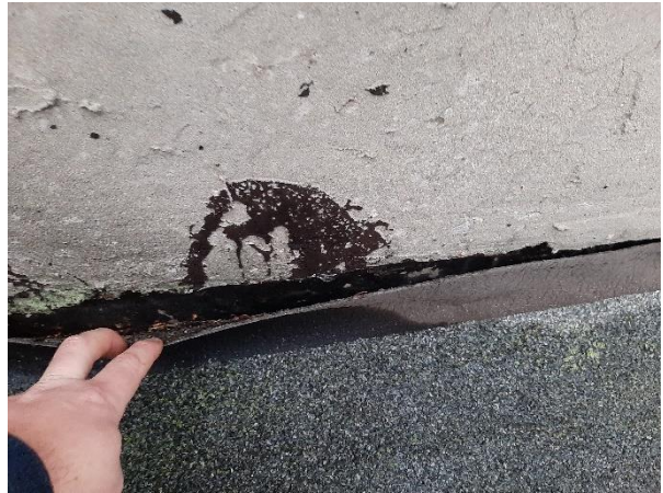
4.6.86. att. Jumta seguma uzlocījumiem nav ierīkotas piespiedējlīstes, iespējama mitruma nokļūšana aiz seguma
