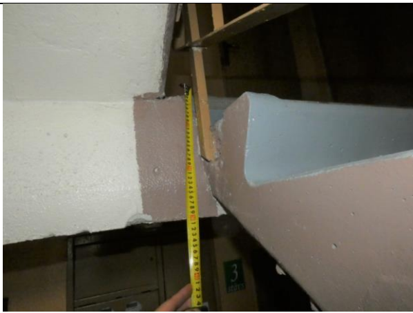
4.8.3.att. 4.8.4.att. Kāpņu laukums un laidums atbilst Projektam. Balsta vieta bez deformācijām.
