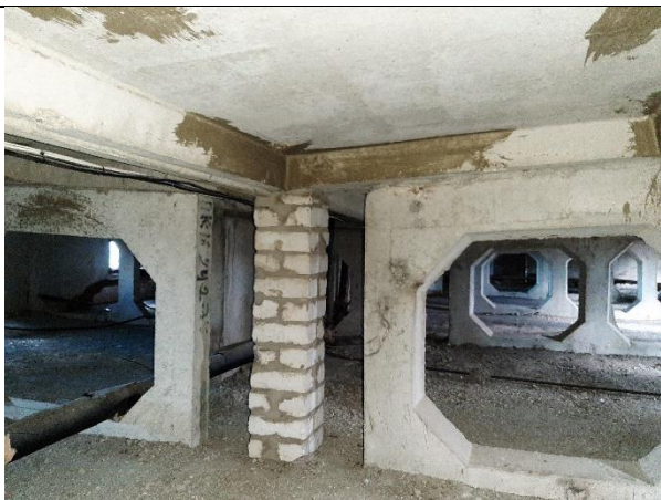
4.6.14.att. Jumta nesošie paneli ПК-15 un ПК-16
