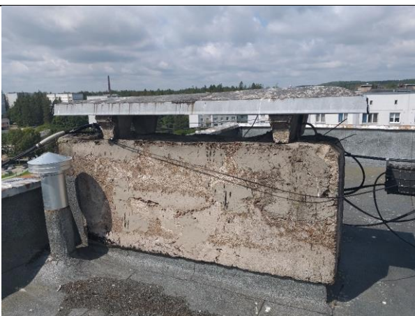
4.10.3.att. 4.10.4. att. Vēntilācijas keramzītbetona bloki ar bojājumiem mitruma un sala ietekmē. Skārda nosedzošie elementi daļēji zuduši un korodējuši.
