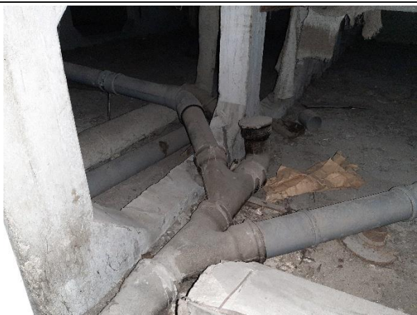
4.6.122. att. Veikta daļēja guļvadu nomainīšana uz PVC
