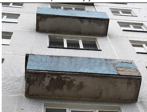
4.7.3.att. 4.7.4.att. Balkonu plātnes un ekrānu betona struktūra ir bojāta mitruma un sala iedarbībā, atsegts, korodējis stiegrojums.
