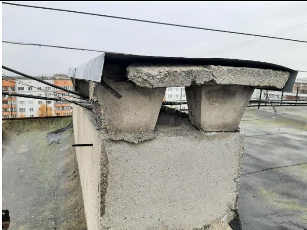
4.10.15. att. 4.10.6. att. Ventilācijas keramzītbetona bloki ar maznozīmīgiem bojājumiem mitruma un sala ietekmē, atsegs un korodējis stiegrojums
