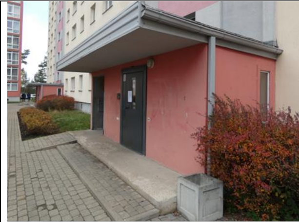
4.7.58.att. Modernizēta risinājuma ieejas mezgls ar ārējo lietus novadīšanas sistēmu. Ēka mikrorajonā Dreiliņi-2, 2007.gadā pabeigti būvdarbi.
