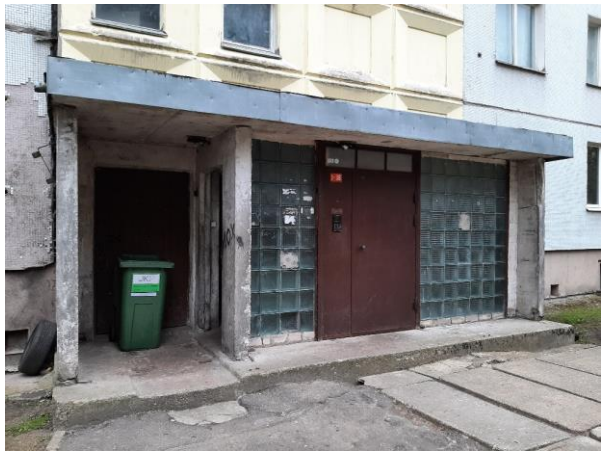
4.7.48.att. 4.7.49.att. Jumiņa dzelzsbetona plātnes betona struktūra un sienas paneļi ir bojāti mitruma un sala iedarbībā. Risinājums atbilst Projekta.
