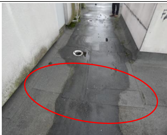
4.6.98.att. Nelīdzens kāpņu telpas izbūves jumta iesegums
