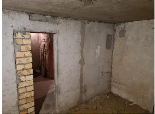
4.2.4. att. Garenienas un šķērssienu panelis ΦП-2, pagraba stāvā, daļēji aizmūrēta aila.
