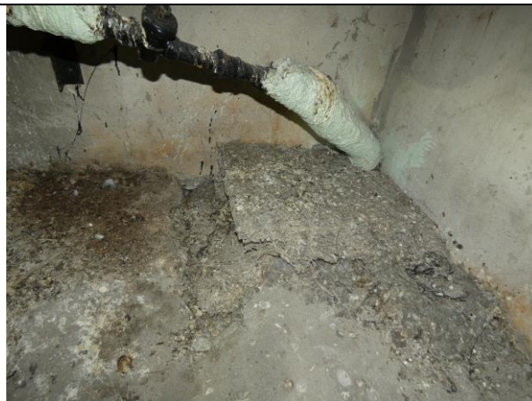
4.3.41. att. Siltumizolācijas kārtā no ~150 mm biezām fibrolīta plāksnēm ar izlīdzinošo javas kārtu 20-30 mm. Slāvu iela 17, Rīga
