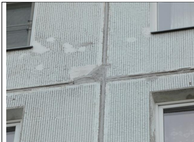
4.2.52. att., 4.2.53. att. Ārsienas paneļi ar flīžu apdares un malu bojājumiem.
