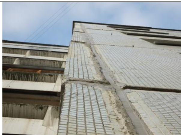
4.2.86.att., 4.2.87.att. Paneļu montāža veikta ar būtiskām novirzēm no vertikālās ass.
