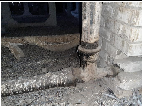
4.6.120. att. Jumta lietus ūdens novadīšanas stāvvads čuguna, saglabājies no ēkas būvniecības laika
