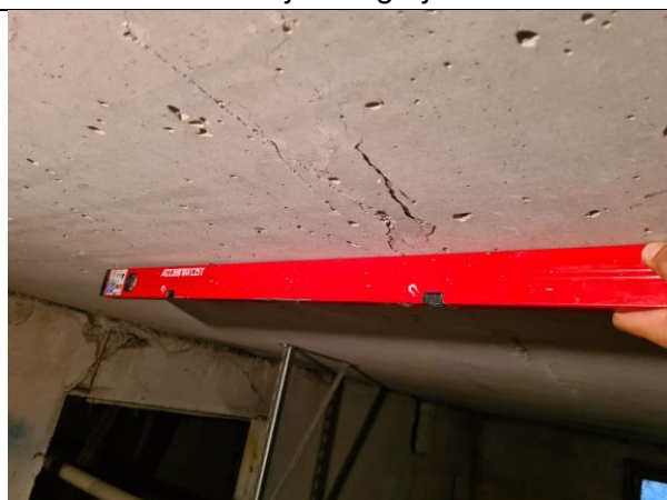
4.4.20. att. Pagraba pārseguma plātne ar plaisu garenvirzienā un izlieci 15 mm (pieļaujamā izliece 12,8 mm, jeb 1/250 no laiduma garuma)
