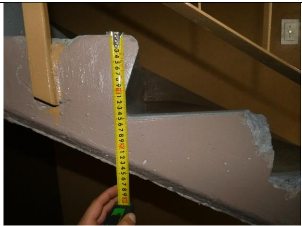
4.8.3.att. 4.8.4.att. Kāpņu laukums un laidums atbilst Projektam. Balsta vieta bez deformācijām.
