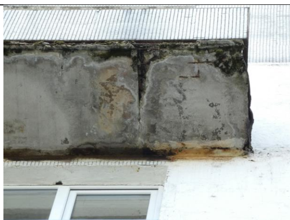
4.7.9.att. 4.7.10.att. Balkonu plātnes betona destrukcija mitruma un sala iedarbībā, stiebrojuma korozija un neatgriezeniskie bojājumi.
