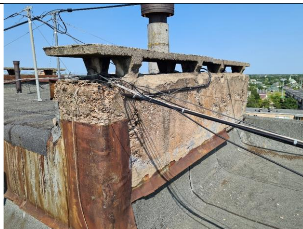
4.10.5. att. 4.10.6. att. Vēntilācijas keramzītbetona bloki ar bojājumiem mitruma un sala ietekmē. Skārda nosedzošie elementi daļēji zuduši un korodējuši.
