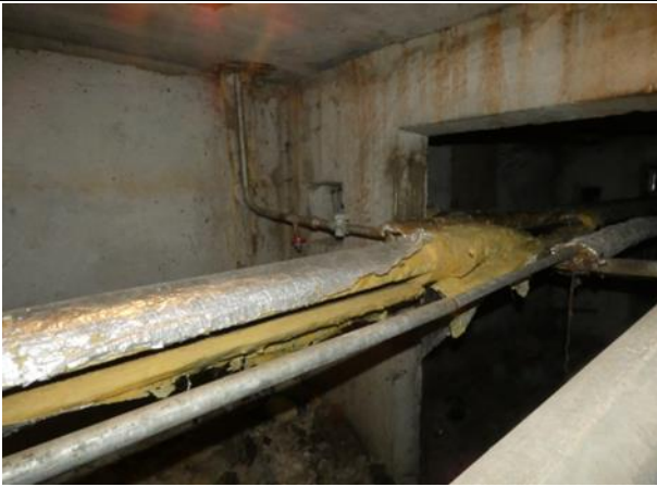
4.2.5.att. Nesošās šķērssienu, cokola pamatu sienas un pārseguma plātnes savienojums bez deformāciju pazīmēm.
