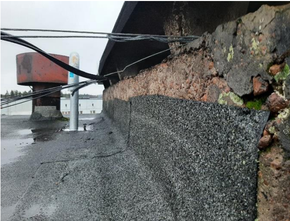
4.6.85. att. Jumta seguma uzlocījumiem nav ierīkotas piespiedējlīstes, iespējama mitruma nokļūšana aiz seguma
