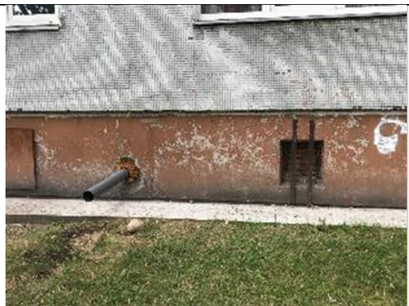
4.1.4.att. Aizsargapmale – lokālie iesēdumi
