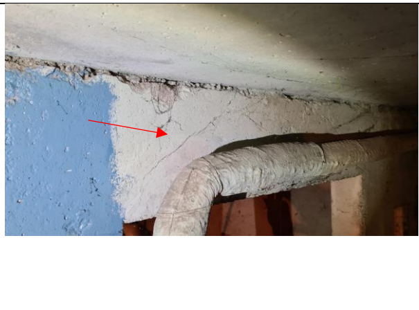
4.2.8. att. Plaisas virs ailas šķērssienu panelī
