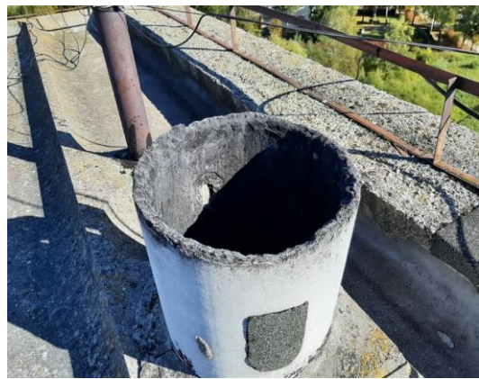
4.9.4. att. Atkritumu vada ventilācijas izvads bez nosegmentiņa
