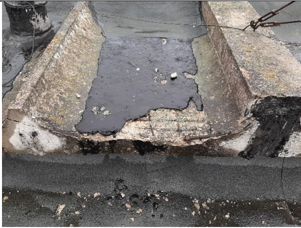
4.6.75.att. Mitruma un sala ietekmē bojāti jumta klāja elementi, atsegts un korodējis stiegorjums
