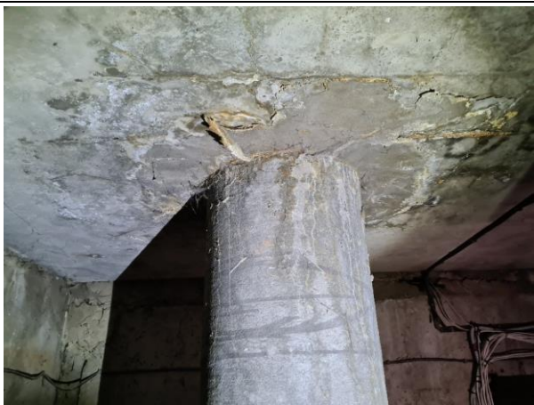
4.6.54.att. Tehniskās telpas (virs 9.stāva) savietotā jumta pārseguma plātne ar mitruma bojājumiem. Sk. kopā ar att. 4.6.11.
