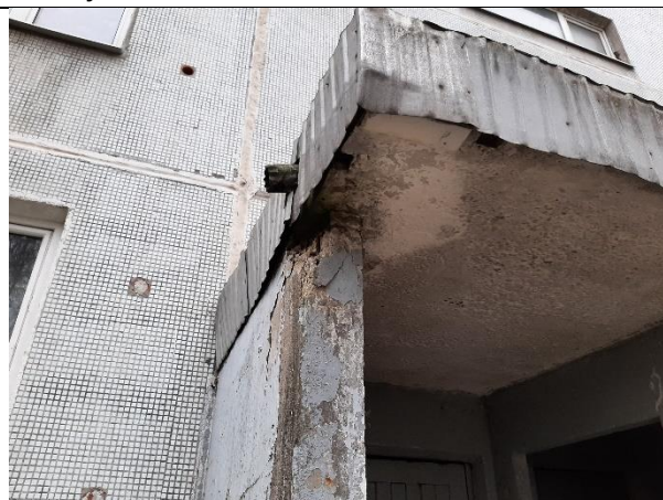
4.7.56.att. 4.7.57.att. Jumtiņa dzelzsbetona plātnes betona struktūra un sienas paneļi ir bojāti mitruma un sala iedarbībā, atsegts, korodējis stiebrojums.
