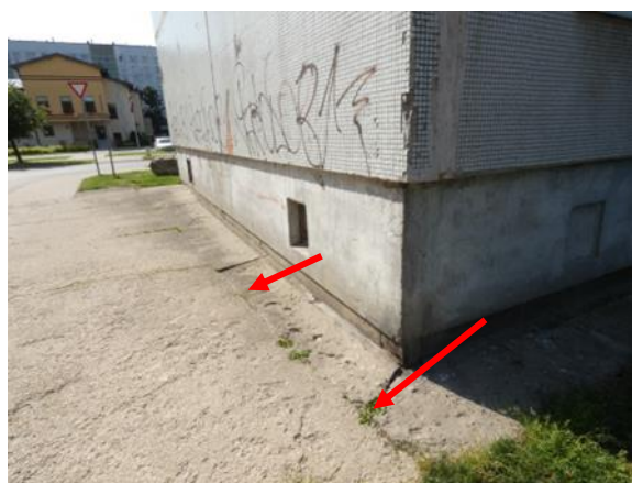
4.1.17. att. Betona apmales plaisa un sēšanā.
