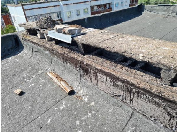
4.10.13. att. 4.10.14. att. Ventilācijas keramzītbetona bloki ar bojājumiem mitruma un sala ietekmē
