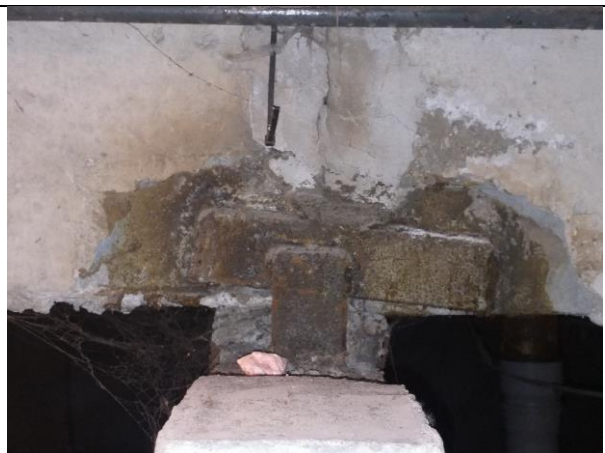
4.6.25.att. Teknes elementu balsta vieta uz jumta paneļa, stiprināšanas detaļu korozija Plaisa virs teknes nesošā stiebrojuma nepietiekamas betona aizsargkārtas dēļ.
