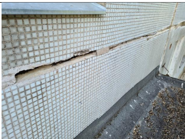
4.3.25. att. 4.3.26. att. Bojāts starppaneļu šuvju aizpildījums.
