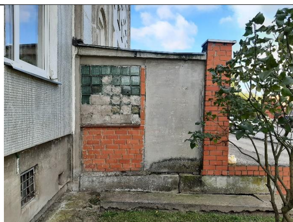
4.7.54.att. 4.7.55.att. Galvenās ieejas mezgls ar māla ķieģeļu un stikla bloku pielietojumu. Atbilst Projekta risinājumiem.
