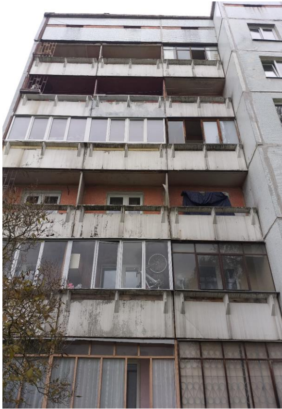
4.7.20. att. Skats uz 6-stāvu ēkas lodžijām.
