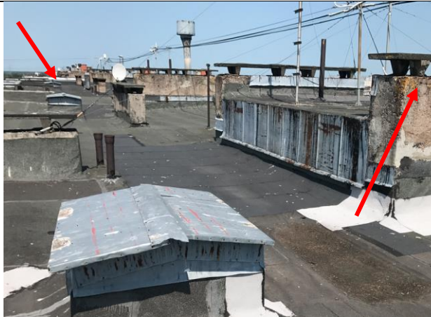
4.10.8.att. Vēdkanālu keramzītbetona bloku izvadi virs kāpņu telpas.
