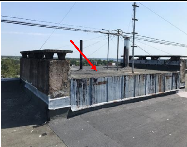
4.6.98.att. Nelīdzens kāpņu telpas izbūves jumta iesegums
