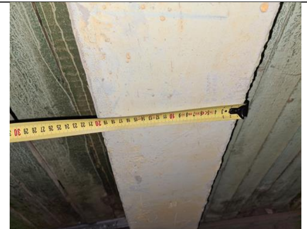
4.2.12. att. Nesošās šķērssienu parametri atbilstoši projektam.
