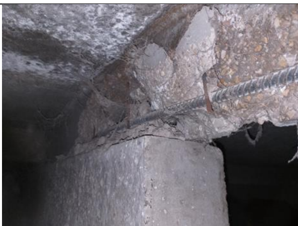
4.6.38.att. Jumta plātnes ribu izliece un vertikālās plaisas
