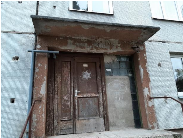
4.7.68.att. Mitruma ietekmē bojāta jumta plātne
