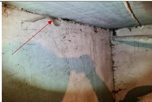
4.3.39. attēls. Horizontālā hidroizolācija virs paneļiem
