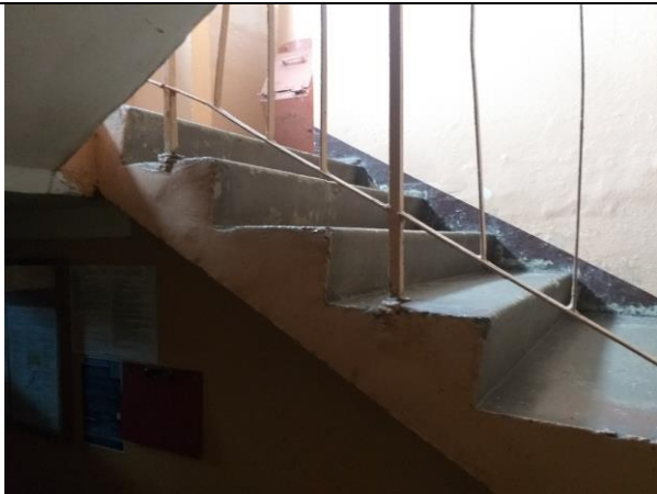
4.8.3.att. 4.8.4.att. Kāpņu laukums un laidums atbilst Projektam. Balsta vieta bez deformācijām.
