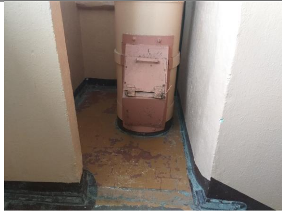
4.9.2. attēls. Atkritumu vada stāvvads ar lūku, labā tehniskajā stāvoklī
