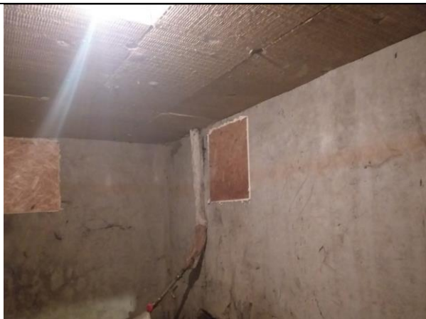
4.3.40.att. Pēc īpašnieku iniciatīvas uzsākta pagraba pārseguma siltumizolēšana.
