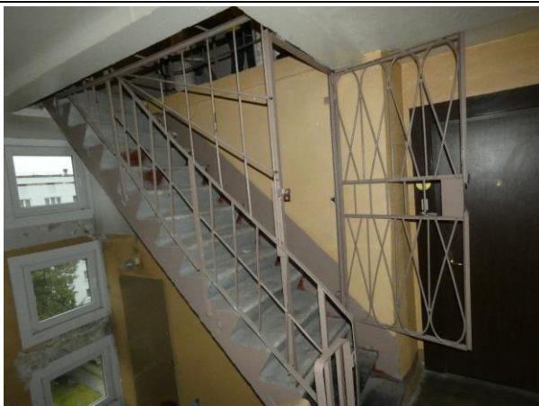
4.8.25.att. Kāpnes no 9.stāva nokļūšanai uz tehniskajām un bēniņu telpām.
