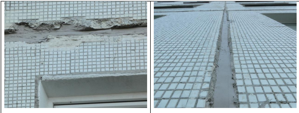
4.3.34. att., 4.3.35.att. Atjaunots starppaneļu šuvju aizpildījums.
