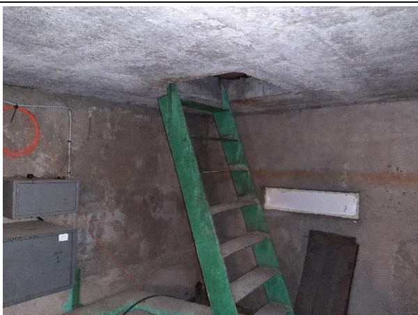
4.8.27.att. 4.8.28.att. Metāla konstrukcijas kāpnes nokļūšanai no bēniņiem uz jumta.
