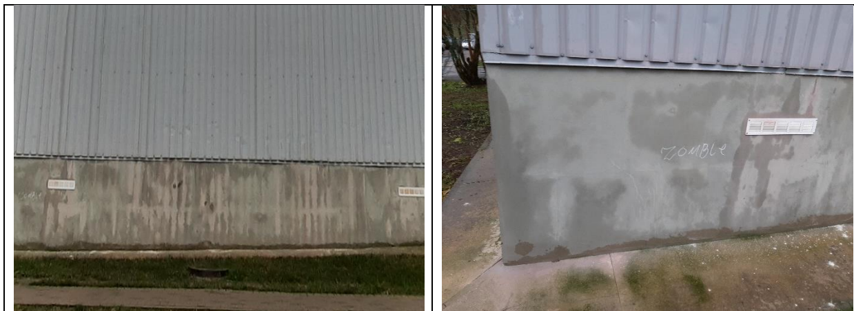
4.2.67. att. 4.2.68. att. Uz cokola apdares izveidojušies plankumi notecējumu rezultātā metāla loksnēm
