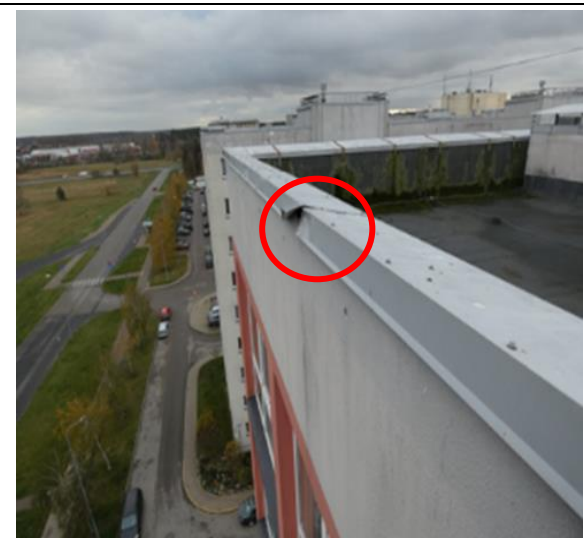
4.6.91. Parapeta virsma nav aizsargāta pret atmosfēras apstākļu iedarbības
