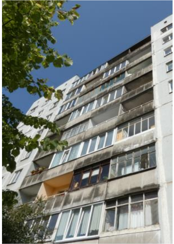
4.7.21. att. Skats uz 9-stāvu ēkas lodžijām.
