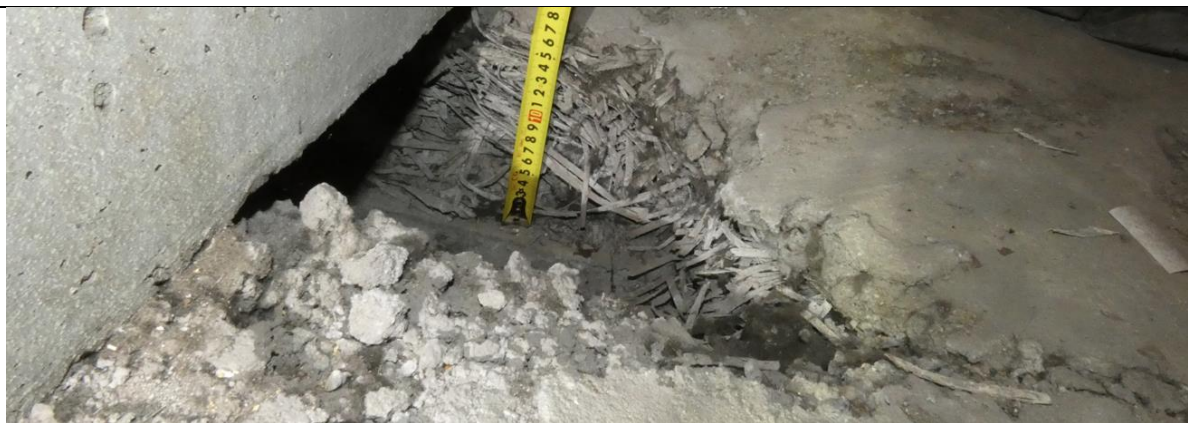
4.3.42. att. Siltumizolācijas kārtā no ~150 mm biezām fibrolīta plāksnēm ar izlīdzinošo javas kārtu 20-30 mm.
