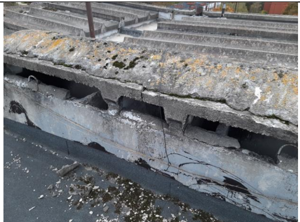
4.10.17. att. 4.10.18. att. Ventilācijas keramzītbetona bloki ar bojājumiem mitruma un sala ietekmē
