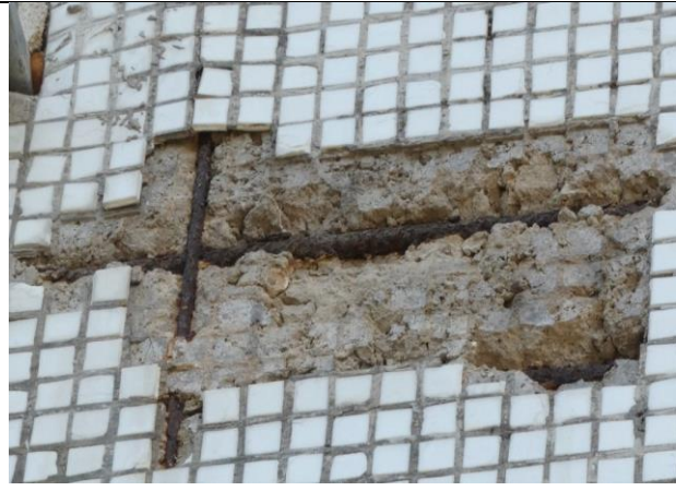
4.2.43., 4.2.44. att. Ārsienas paneļu mozaīkas apdares izdrupumi un atsegts korodējis stiegrojums, ar nepietiekamu aizsargkārtu. Bojājumu cēloņi - ražošanas defekti.
