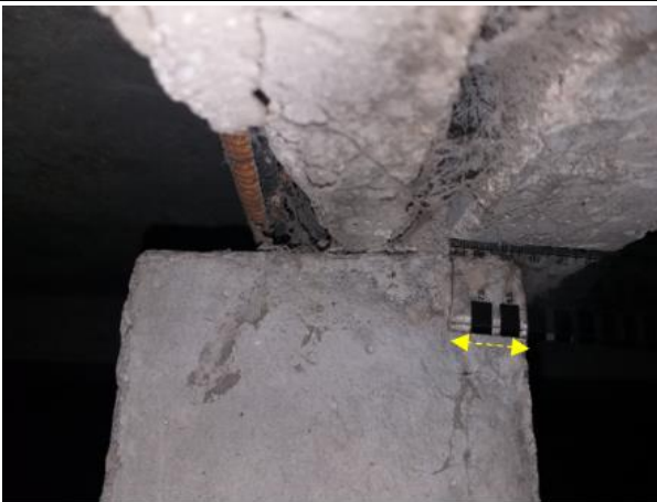
4.6.50.att. Jumta plātnes ribas balstījums – 25 mm.
