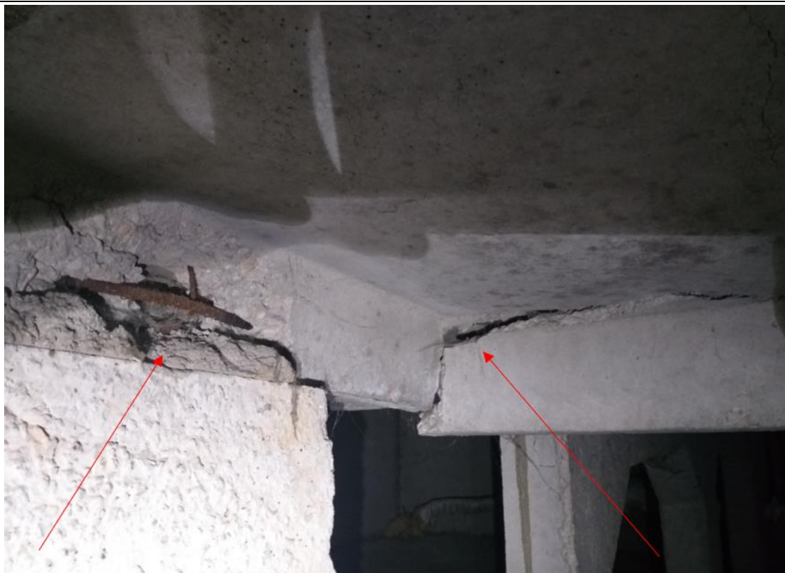
4.6.34.att. Ēkas 1.sekcijā jumta plātnes riba deformāciju rezultātā pārlūzusi. Balsta vietā – atšķelts betons. Nepieciešams nekavējoties izstrādāt tehnisko risinājumu un veikt konstrukciju pastiprināšanu.
