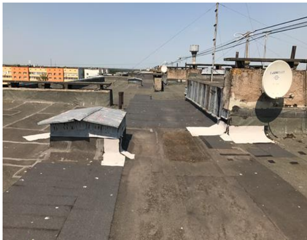
4.6.97.att. Bojāta jumta hidroizolācijas virskārta
