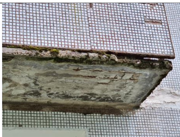
4.7.7. att., 4.7.8. att. Balkonu plātnes betona destrukcija, pilnībā bojāts stiebrojums. Ekrānu bojājumi.
