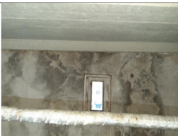
4.2.65. att. 4.2.66. att. Plaisas ārsienu paneļos, mitruma ietekmē bojāti ārsienu paneļi
