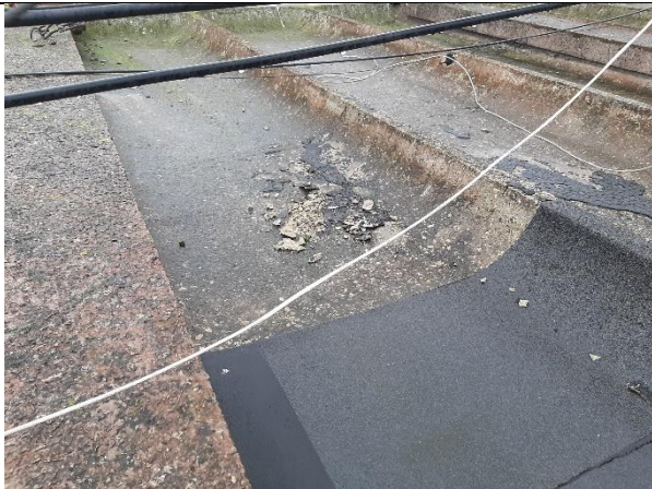
4.6.77.att. Mitruma un sala ietekmē bojāti jumta klāja elementi
