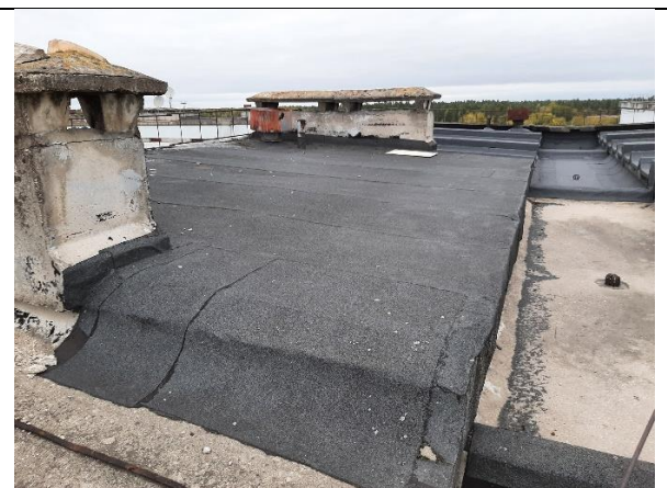
4.3.53.att. Kāpņu telpas savietotā jumta siltumizolācija ierīkota pilnā apjomā.
