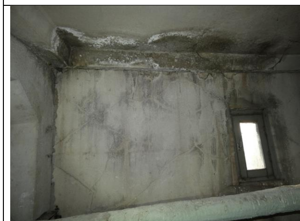
4.2.63. att. 4.2.64. att. Mitruma radīti bojājumi jumta klāja plātnēm un ārsienu paneļiem. Plaisu tīkls.
