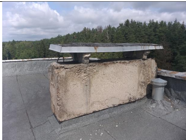
4.10.1.att., 4.10.2. att. Keramzītbetona vēntilācijas bloks ar strukturāliem bojājumiem un deformētiem naselementiem.
