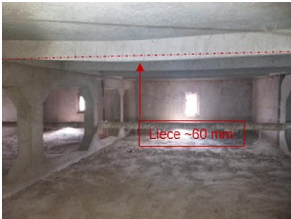
4.6.36.att. Jumta plātnes ribu izliece ~ 60 mm.
