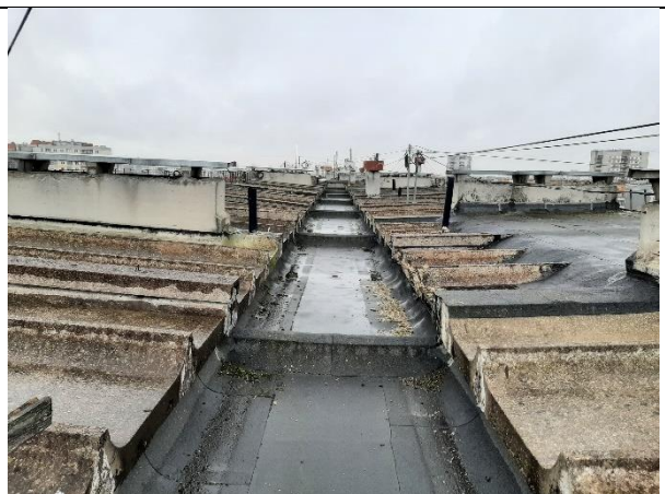
4.6.78.att. Mitruma un sala ietekmē bojāti jumta klāja elementi, atsegts un korodējis stiegorjums
