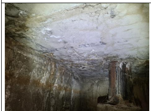
4.2.54. att. Notecējumi uz ārsienas paneļa no telpas iekšpuses
