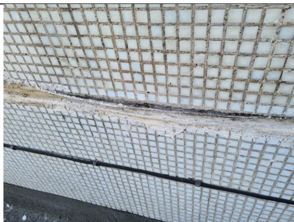
4.3.25. att. 4.3.26. att. Bojāts starppaneļu šuvju aizpildījums.
