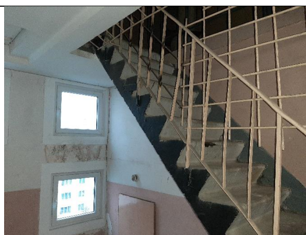
4.8.18.att. Kāpnes uz bēniņiem, dzelzsbetona laidums ar metāla margām.
