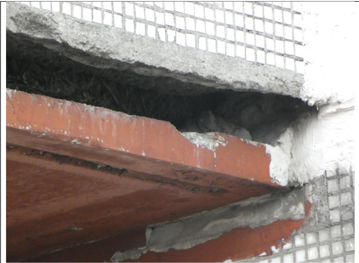
4.3.45., 4.3.46., 4.3.47.att. Nehermetisks ārsienas frīzes paneļa un virs lodžijas pārseguma plātnes pieslēgums, bēniņu pārseguma siltumizolācijas vietā.
