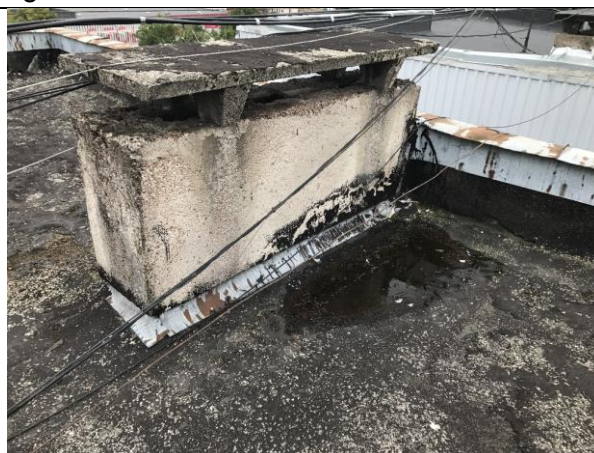
4.10.3.att. 4.10.4. att. Vēntilācijas keramzītbetona bloki ar bojājumiem mitruma un sala ietekmē. Skārda nosedzošie elementi daļēji zuduši un korodējuši.
