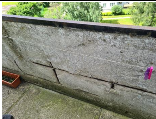
4.7.16. att. Balkona ekrānam stiegrojums bez aizsargkārtas – ražošanas un klimatisko faktoru rezultāts.
