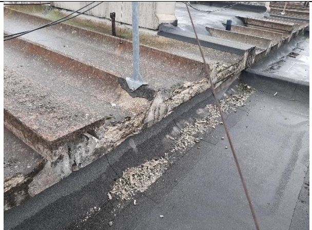
4.6.78.att. Mitruma un sala ietekmē bojāti jumta klāja elementi, atsegts un korodējis stiegorjums
