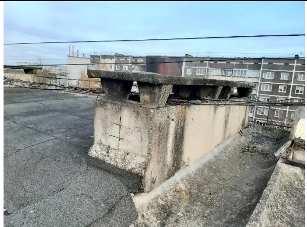
4.10.15. att. 4.10.6. att. Ventilācijas keramzītbetona bloki ar maznozīmīgiem bojājumiem mitruma un sala ietekmē, atsegs un korodējis stiegrojums
