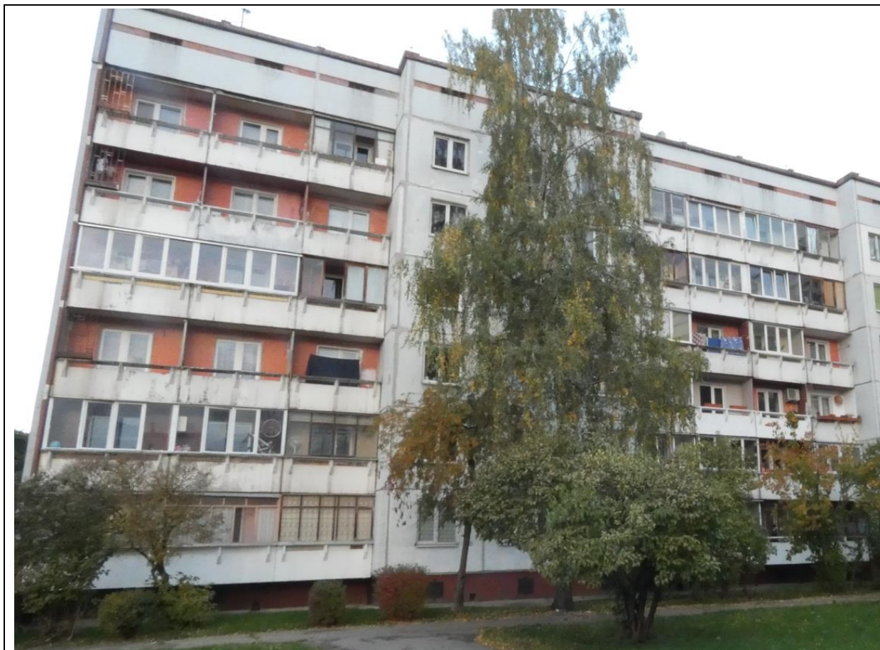
4.7.19. att. Skats uz 6-stāvu ēkas lodžijām.
