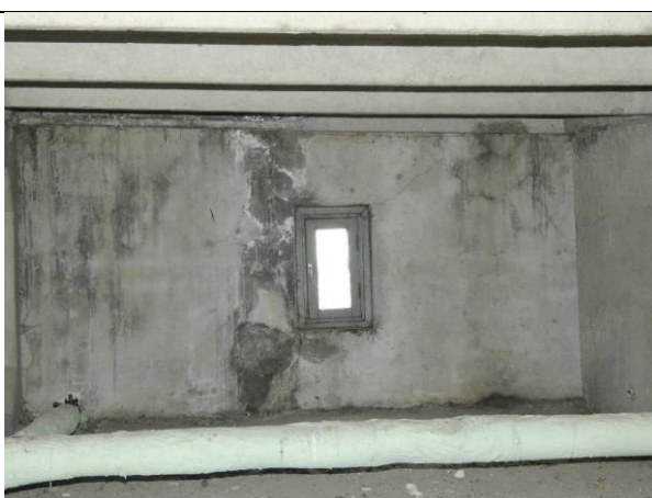
4.2.63. att. 4.2.64. att. Mitruma radīti bojājumi jumta klāja plātnēm un ārsienu paneļiem. Plaisu tīkls.
