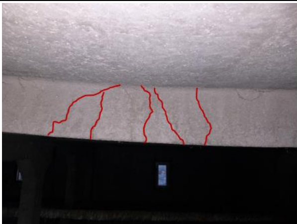
4.6.38.att. Jumta plātnes ribu izliece un vertikālās plaisas
