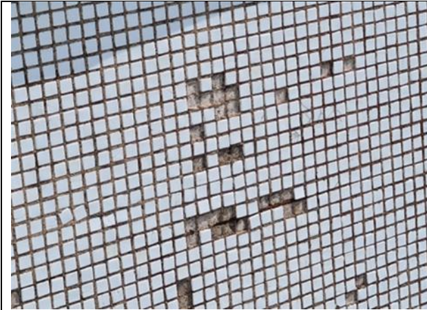
4.2.43., 4.2.44. att. Ārsienas paneļu mozaīkas apdares izdrupumi un atsegts korodējis stiegrojums, ar nepietiekamu aizsargkārtu. Bojājumu cēloņi - ražošanas defekti.
