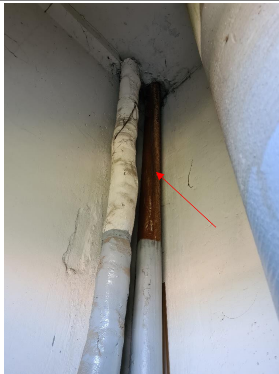
4.6.113. att. Jumta lietus ūdens novadīšanas ķeta stāvvads, saglabājies no ēkas būvniecības laika
