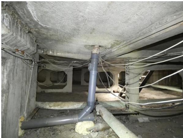
4.6.116. att. Jumta lietus ūdens novadīšanas PVC cauruļvadi labā stāvoklī
