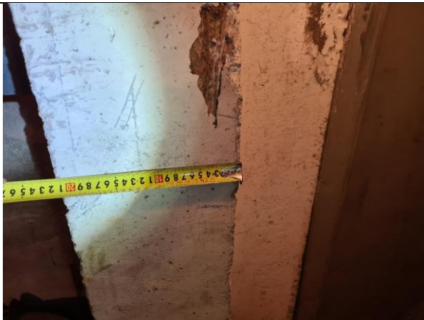
4.2.11. att. Garensienas panelis ФП-14 210 mm biezumā
