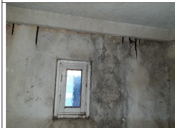
4.2.65. att. 4.2.66. att. Plaisas ārsienu paneļos, mitruma ietekmē bojāti ārsienu paneļi
