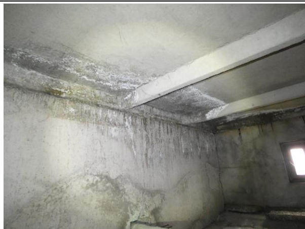
4.6.55.att. Pārseguma plātne ar mitruma bojājumiem un neatbilstošu aizsargkārtu (pielietots nekvalitatīvs būvizstrādājums)
