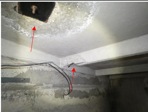
4.6.54.att. Tehniskās telpas (virs 9.stāva) savietotā jumta pārseguma plātne ar mitruma bojājumiem. Sk. kopā ar att. 4.6.11.
