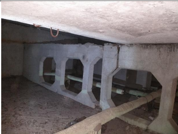
4.6.18.att. Jumta nesošie paneli PK-17 un teknes elements Λ64-21-1
