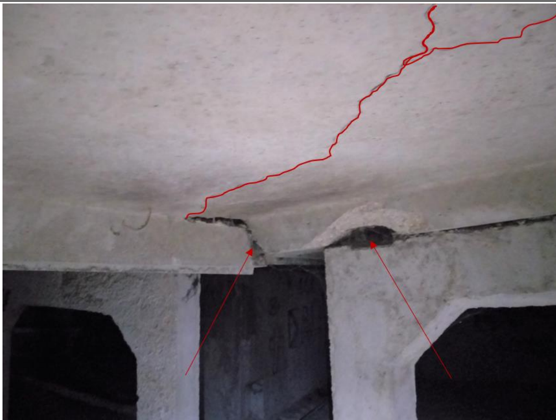
4.6.34.att. Ēkas 1.sekcijā jumta plātnes riba deformāciju rezultātā pārlūzusi. Balsta vietā – atšķelts betons. Nepieciešams nekavējoties izstrādāt tehnisko risinājumu un veikt konstrukciju pastiprināšanu.
