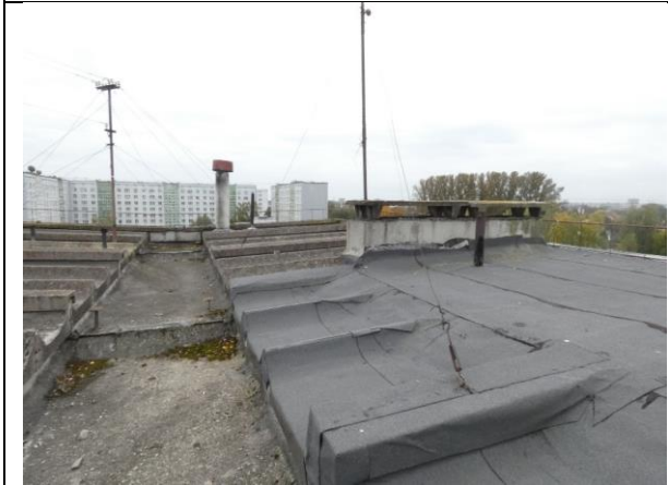
4.3.50., 4.3.51.att. Kāpņu telpas savietotā jumta siltumizolācija ierīkota daļējā apjomā.
