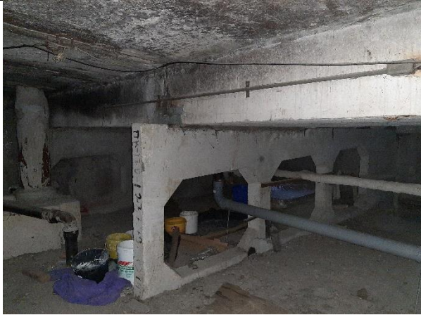
4.6.16.att. Jumta nesošie paneli PK-17 un teknes elements Λ64-21-1
