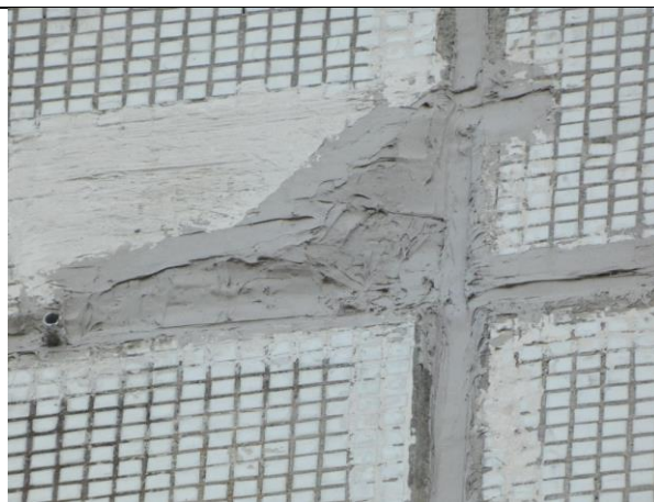
4.2.52. att., 4.2.53. att. Ārsienas paneļi ar flīžu apdares un malu bojājumiem.
