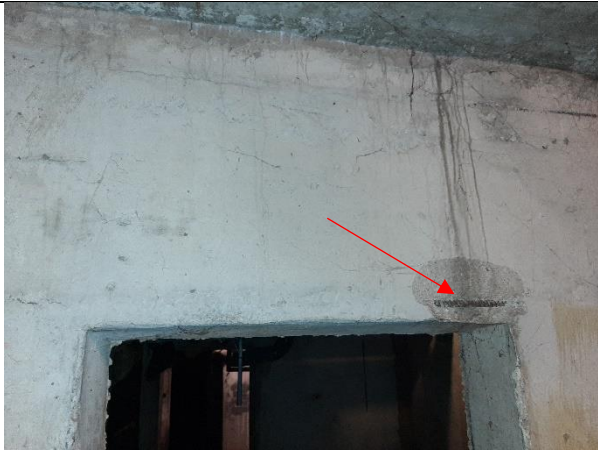
4.2.17. att. Neatbilstošs aizsargslānis, atsegts stiegrojums
