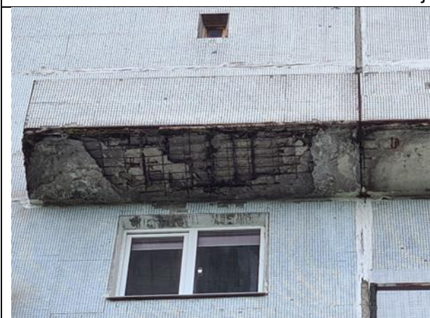
4.7.9.att. 4.7.10.att. Balkonu plātnes betona destrukcija mitruma un sala iedarbībā, stiebrojuma korozija un neatgriezeniskie bojājumi.
