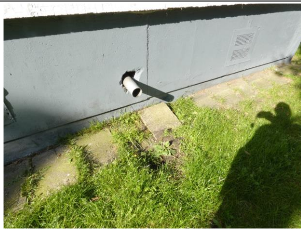
4.6.125. att. Lietus ūdens tiek novadīts gruntī ēkas tuvumā, bojājot aizsargapmali
