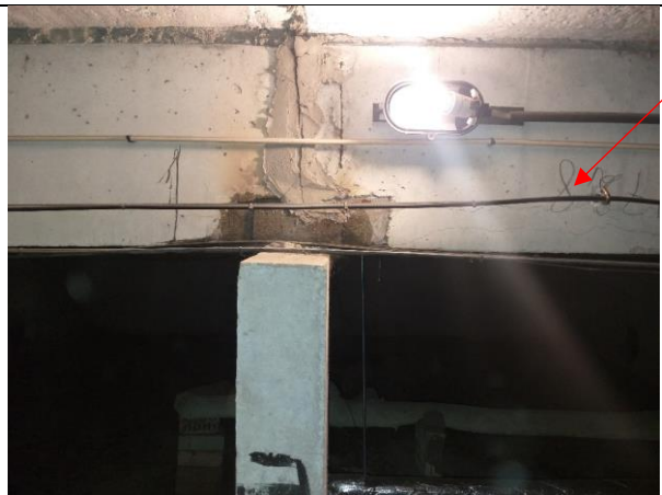
4.6.25.att. Teknes elementu balsta vieta uz jumta paneļa, stiprināšanas detaļu korozija Plaisa virs teknes nesošā stiebrojuma nepietiekamas betona aizsargkārtas dēļ.
