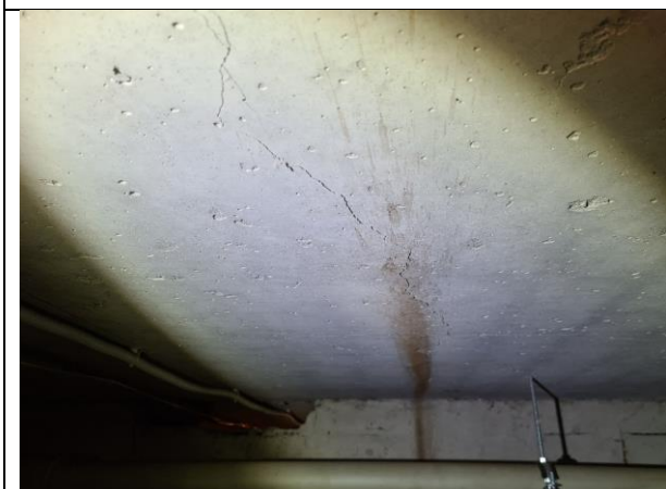
4.4.19. att. Pagraba pārseguma plātne ar mikroplaisām, kas būtiski neietekmē tās nestspēju. Izliece nav konstatēta.
