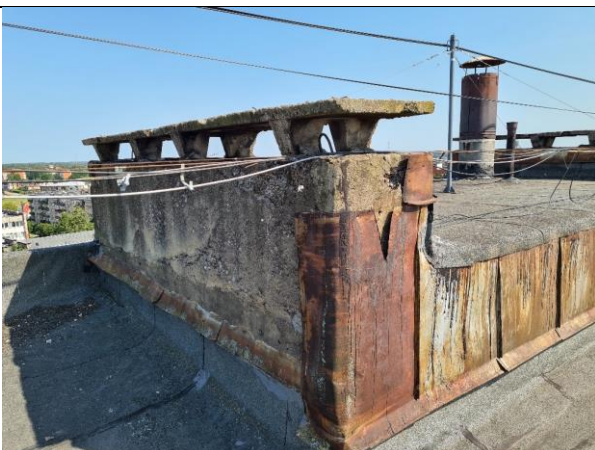
4.10.5. att. 4.10.6. att. Vēntilācijas keramzītbetona bloki ar bojājumiem mitruma un sala ietekmē. Skārda nosedzošie elementi daļēji zuduši un korodējuši.
