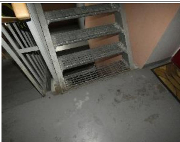
4.8.23.att. Kāpnes balstās uz 9.stāva kāpņu laukuma
