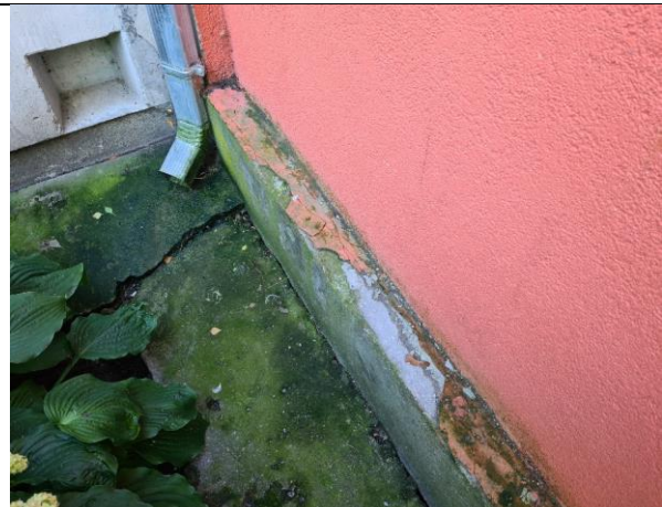
4.1.5.att. Aizsargapmale saplaisājusi pavirši izpildītu būvdarbu rezultātā.
