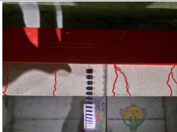
4.6.37.att. Jumta plātnes ribas izliece ~ 60 mm. Vertikālās plaisas.
