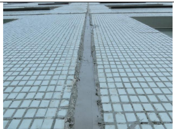
4.3.8.att. Veikta šuvju atjaunošana pilnā apjomā – esošā aizpildījuma demontāža,
