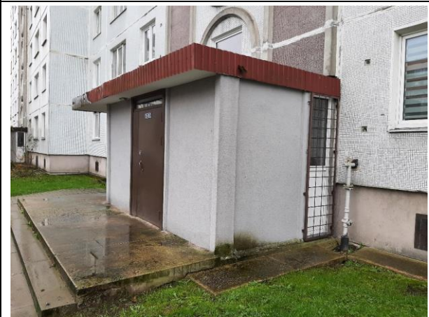
4.7.60.att. Nokrišņi no jumtiņa novadīti uz sienām un ieejas mezgla apmales, veidojot apaugumu
