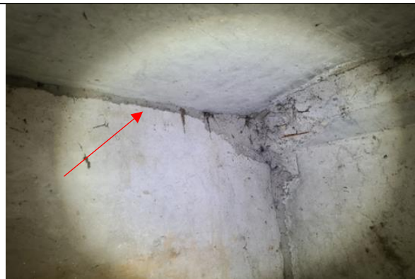
4.3.38. attēls. Horizontālā hidroizolācija
