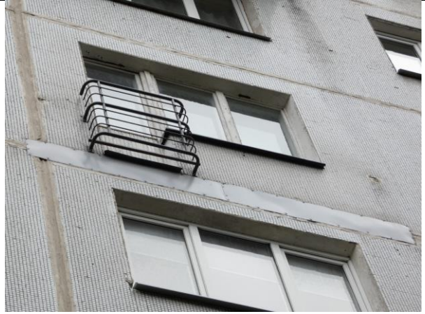
4.7.12.att. Demontēta balkona plātne, izbūvēta franču balkona tipa norobežojošā konstrukcija.
