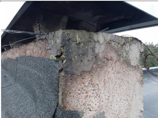
4.10.17. att. 4.10.18. att. Ventilācijas keramzītbetona bloki ar bojājumiem mitruma un sala ietekmē
