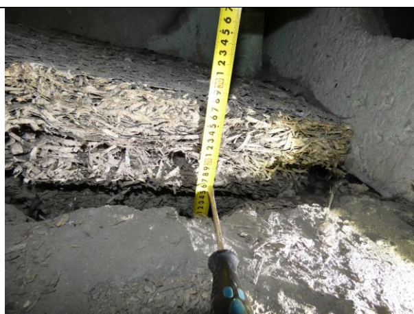
4.3.43. att. 4.3.44.att. Siltumizolācijas kārtā no ~150 mm biezām fibrolīta plāksnēm ar izlīdzinošo javas kārtu 20-30 mm. Zonā virs lodžiju pārseguma ierīkota papildus siltumizolācijas kārtā ar ~100 mm biezām fibrolīta plāksnēm.
