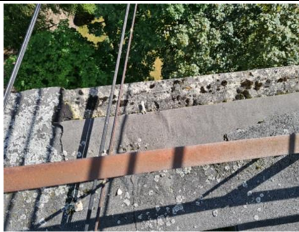
4.6.91. Parapeta virsma nav aizsargāta pret atmosfēras apstākļu iedarbības
