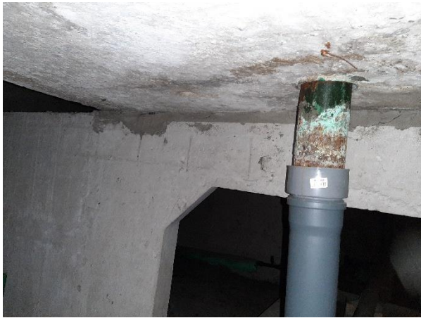
4.6.114. att. Čuguna izvadi, saglabājušies no ēkas celtniecības laika
