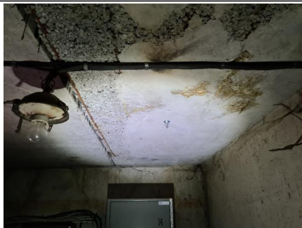
4.6.55.att. Pārseguma plātne ar mitruma bojājumiem un neatbilstošu aizsargkārtu (pielietots nekvalitatīvs būvizstrādājums)
