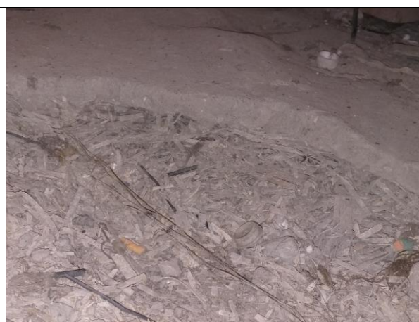
4.3.43. att. 4.3.44.att. Siltumizolācijas kārtā no ~150 mm biezām fibrolīta plāksnēm ar izlīdzinošo javas kārtu 20-30 mm. Zonā virs lodžiju pārseguma ierīkota papildus siltumizolācijas kārtā ar ~100 mm biezām fibrolīta plāksnēm.
