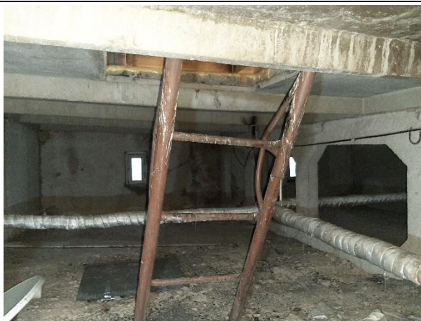
4.8.26.att. Metāla cauruļu konstrukcijas kāpnes nokļūšanai no bēniņiem uz jumta.
