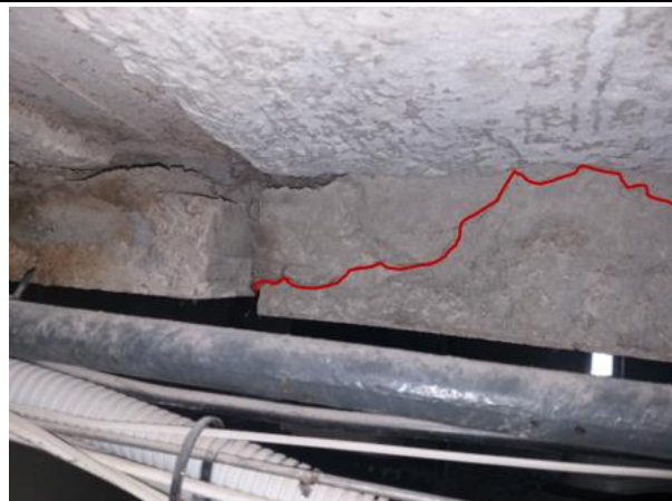
4.6.39.att. Jumta plātņu montāžas neprecizitātes, lūzumi un notikušās deformācijas.
