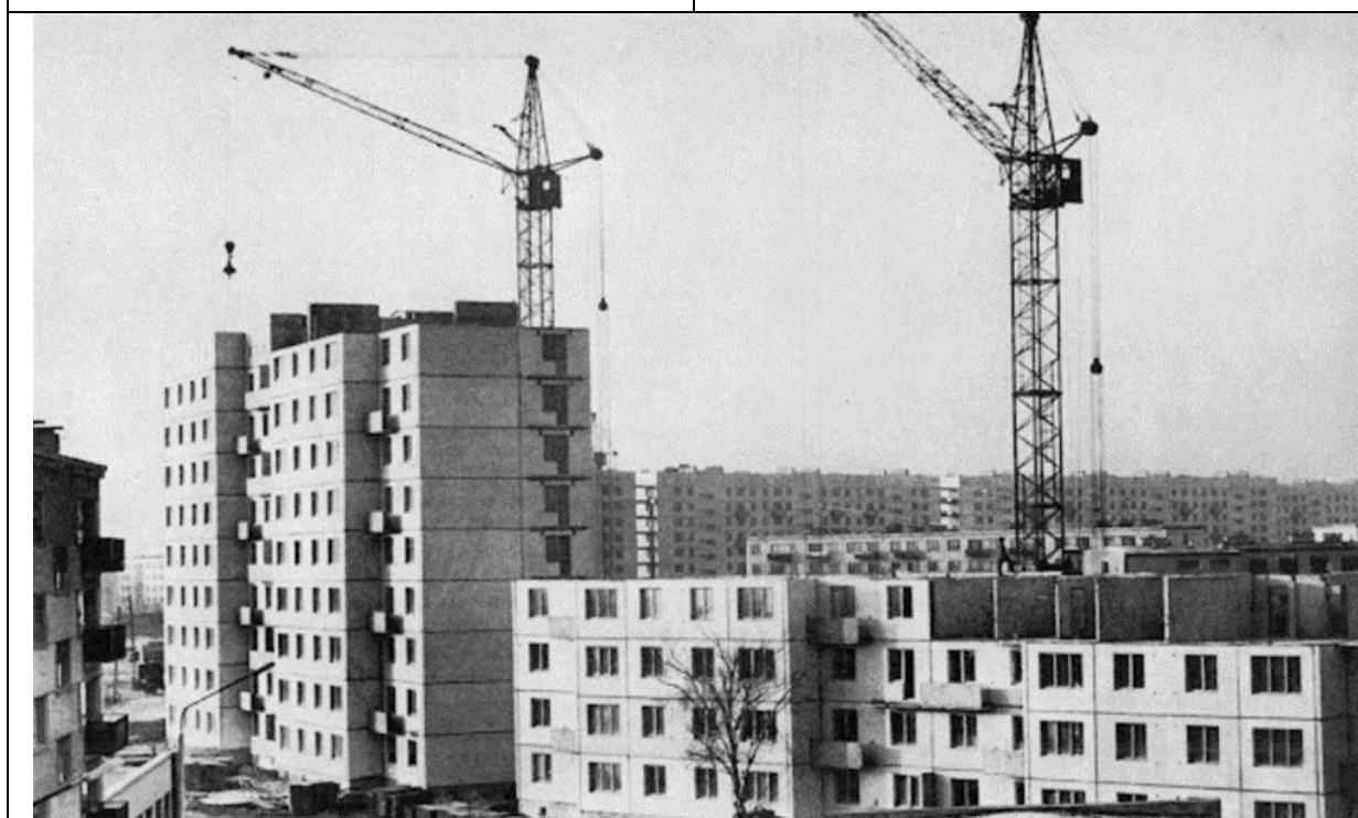
1970-tie gadi. 602 sērijas mājas būvē Stirnu ielā, Rīgā. Pirmais variants ar balkoniem.
