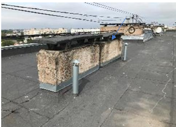
4.10.1.att., 4.10.2. att. Keramzītbetona vēntilācijas bloks ar strukturāliem bojājumiem un deformētiem naselementiem.
