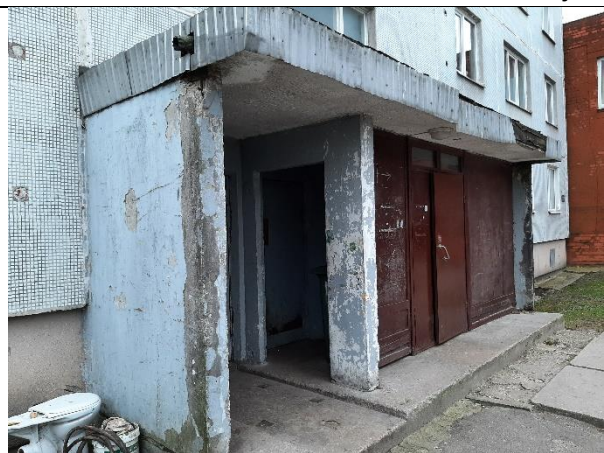
4.7.56.att. 4.7.57.att. Jumtiņa dzelzsbetona plātnes betona struktūra un sienas paneļi ir bojāti mitruma un sala iedarbībā, atsegts, korodējis stiebrojums.
