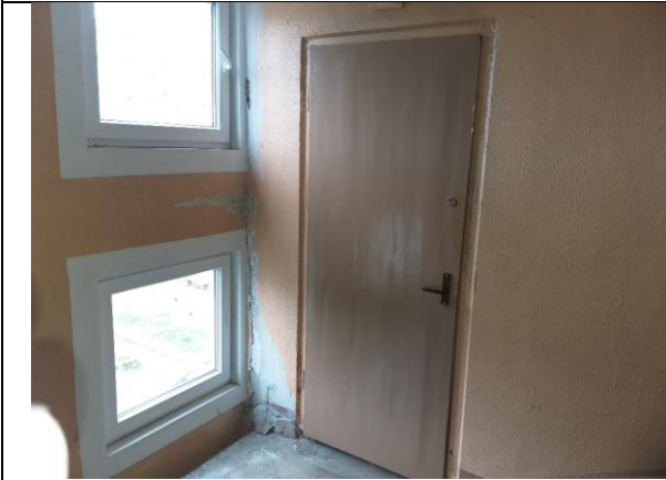
4.9.1. attēls. Atkritumu vada telpai uzstādītas durvis. Eksploatācija notiek.
