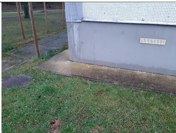
4.1.15. att. Ēkas aizsargapmale ar apaugumu, notecējumu no jumta, rezultātā
