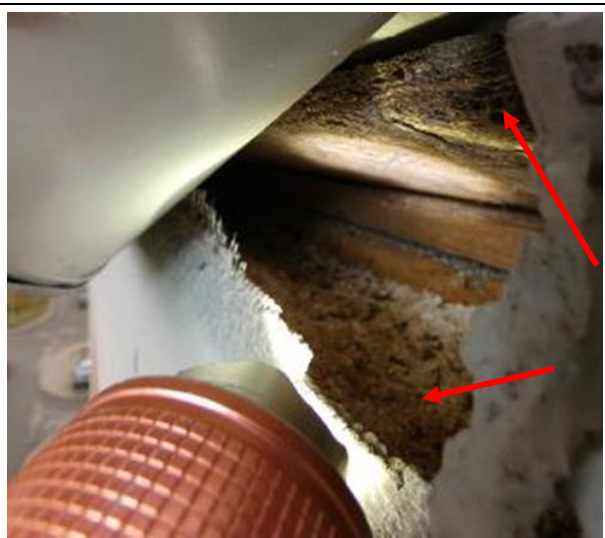
4.6.92.att. Skārda parapetu korozija, skārda bojājumi
