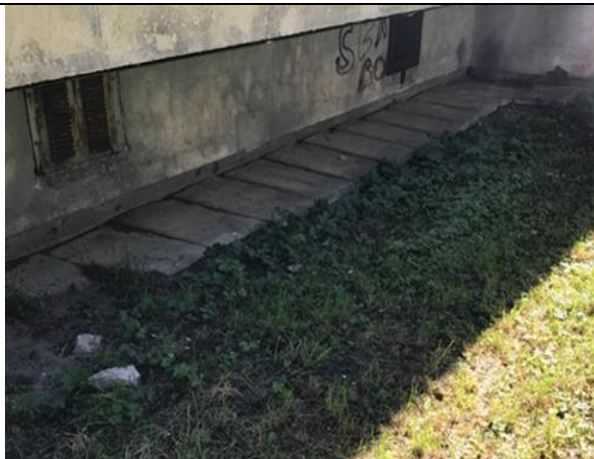
4.1.4.att. Aizsargapmale – lokālie iesēdumi
