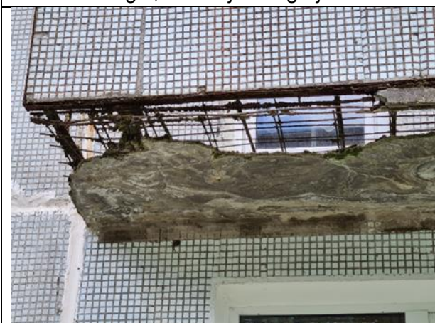
4.7.7. att., 4.7.8. att. Balkonu plātnes betona destrukcija, pilnībā bojāts stiebrojums. Ekrānu bojājumi.
