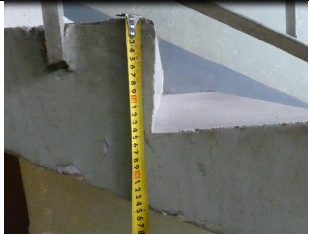
4.8.2. att. Pakāpienu augstums 150 mm
