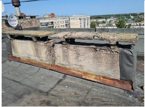
4.10.13. att. 4.10.14. att. Ventilācijas keramzītbetona bloki ar bojājumiem mitruma un sala ietekmē
