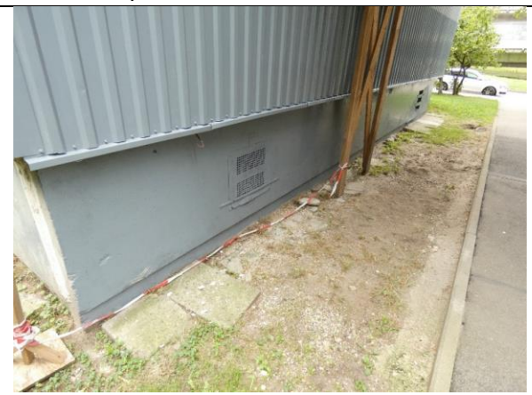
4.1.5.att. Aizsargapmale saplaisājusi pavirši izpildītu būvdarbu rezultātā.
