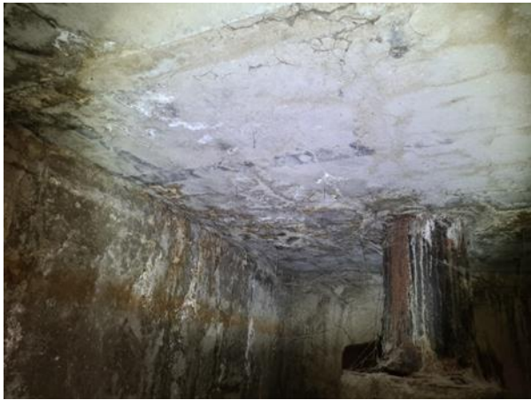
4.6.52.att. Keramzītbetona jumta plātne (augšā) un ārsienas frīzes panelis (pa kreisi) ar mitruma ietekmes pazīmēm.
