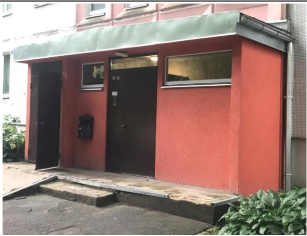
4.7.50.att. 4.7.51.att. No sekcijas ieejas mezgla jumiņa organizēta lietus ūdens novadīšana. Risinājumi neatbilst Projekta, ir veikta pārbūve.
