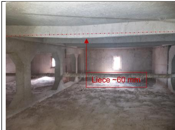
4.6.10.att. Jumta nesošais panelis ПК-15, 140 mm biezumā. Jumta klāja plātnes liece.
