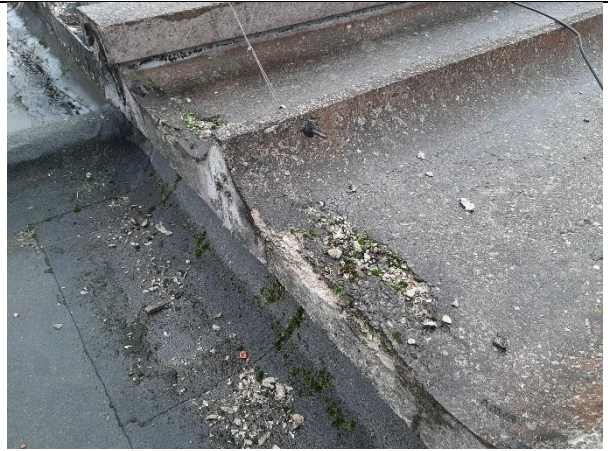
4.6.76.att. Mitruma un sala ietekmē bojāti jumta klāja elementi, atsegts un korodējis stiegorjums
