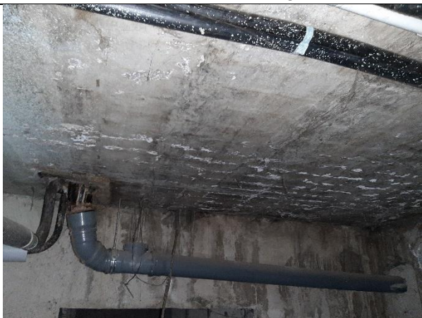
4.4.13. att. Mitruma ietekmē bojāta plātnes struktūra
