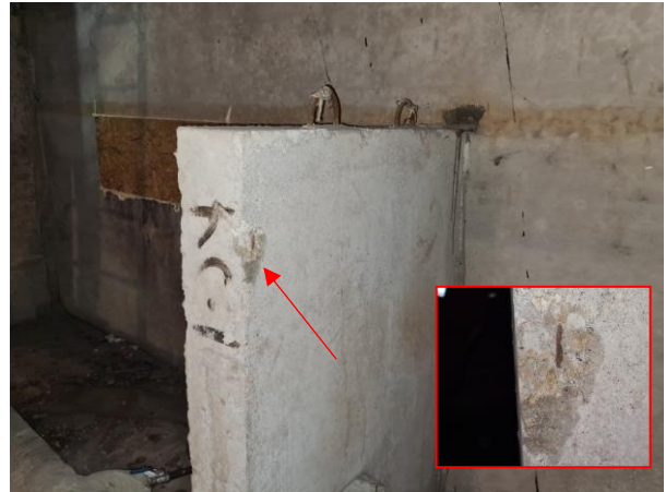
3.2.att. Dobās starpstāvu pārseguma plātnes 1.stāvā. Karbonizētais slānis vairāk par 10 mm. Rudens iela 4, Rīga.
