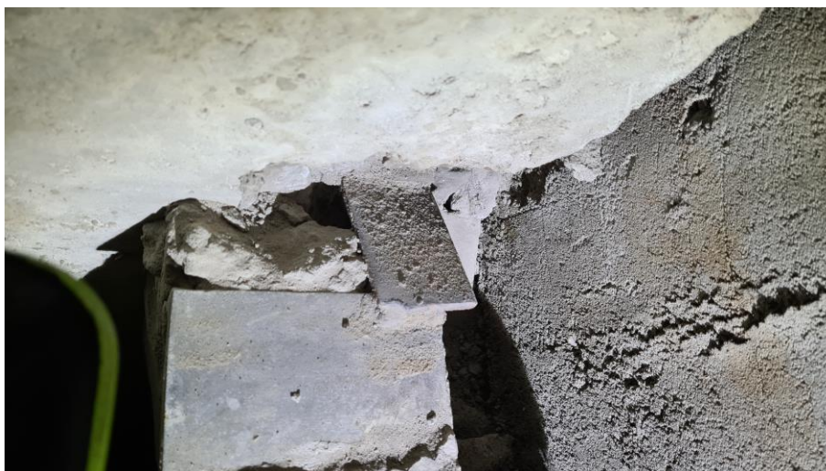
10.3.att. Paneļa CK-1 un ār sienas paneļa stiprinājums ierīkots ar neatbilstošu šuves garumu
