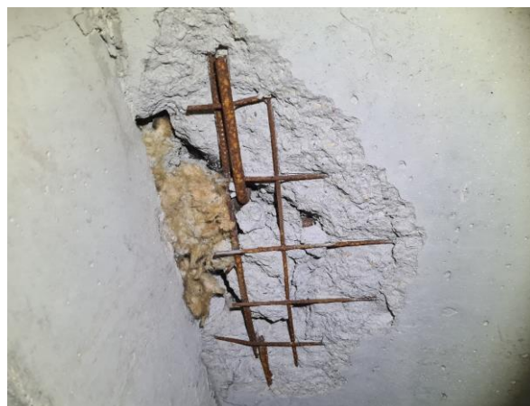
9.6.att. Atseguma 9.1 kopskats. Ierīkots siets d5 100x200 mm atbilstoši Projektam.
