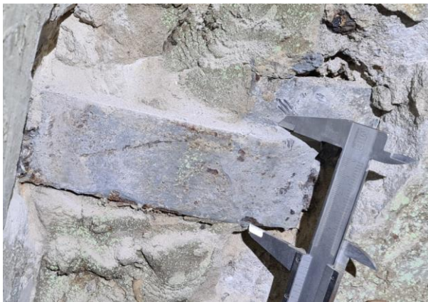
5.3.att. Savienojuma elements – loksne 60x120x8 mm. Ieliekamās detaļas apstrādātas ar auksto cinku, korozijas pazīmes nav konstatētas.
