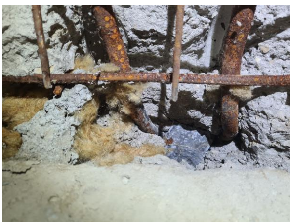
9.10.att. Pārseguma plātnes savienotas savā starpā, sametinot to montāžas cilpas ar plāksni 60x140x8 mm (Nr. 9.2)
