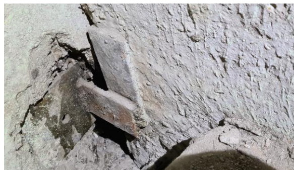
11.2.att. Ieliekamo detaļu tuvplāns.
