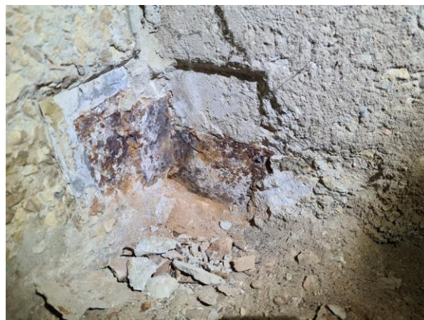
6.2.att. Atsegumā konstatēta šķērssienas un garensienas paneļu ieliekamās detaļas 100x100x8 mm, pie kurām piemetināta savienojošā plāksne 60x100x8 mm. Konstatēti korozijas bojājumi, tomēr būtiska elementu šķērs griezuma samazināšanās nav konstatēta.
