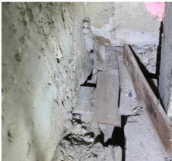
12.2.att. Atseguma vieta 12.1. Pretkorozijas apstrāde nav veikta.
