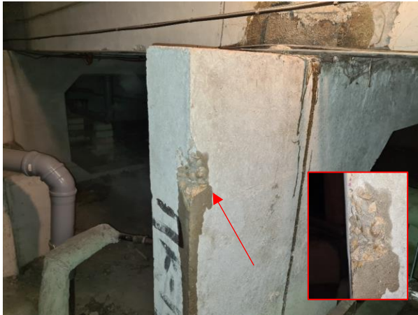
3.1.att. Dobās starpstāvu pārseguma plātnes pagrabā. Karbonizētais slānis vairāk par 10 mm. Rudens iela 4, Rīga.
