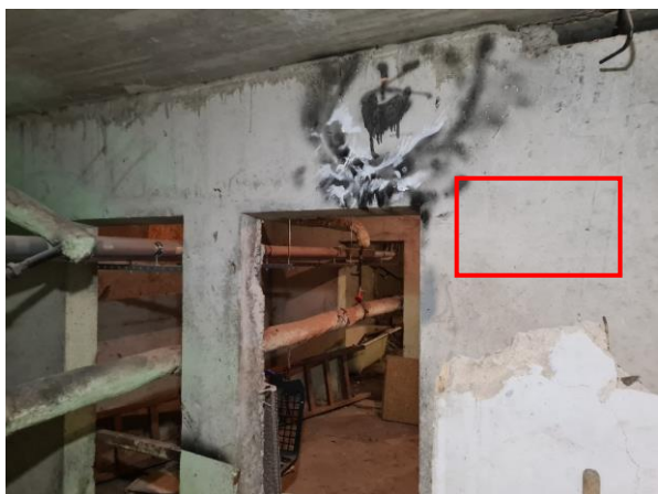
2.13.att. Pagraba nesošās sienas panelis ФП-1. Rudens iela 4, Rīga. Pēc Projekta betona marka M200 (C12/15).
