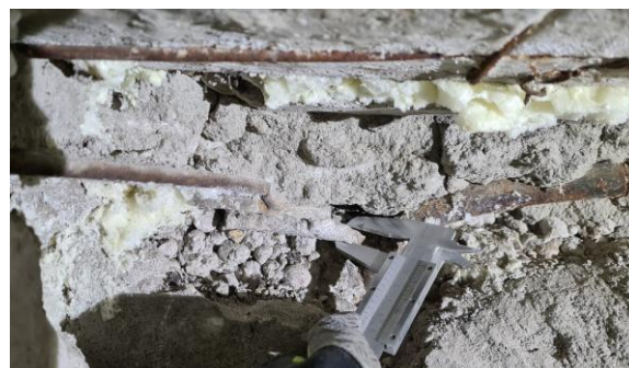
10.2.att. Ieliekamo detaļu tuvplāns
