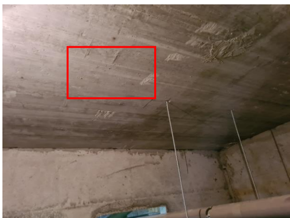
2.17.att. Pagraba pārseguma plātne ПП-2Л. Rudens iela 4, Rīga. Pēc Projekta betona marka M200 (C12/15).
