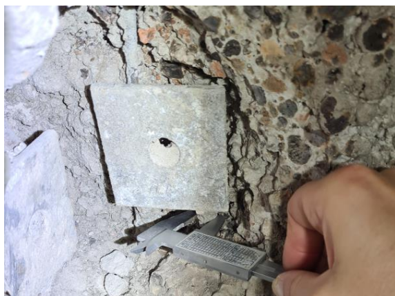
1.3.att. Profilētas stiegras d12, 2 gab. ielikamās detaļās apstrādātas ar auksto cinku, korozijas pazīmes nav konstatētas.
