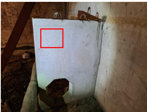
2.3.att. Jumta nesošās konstrukcijas panelis CK-1. Rudens iela 4, Rīga. Pēc Projekta betona marka M200 (C12/15).
