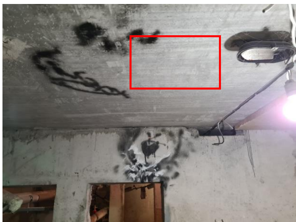
2.15.att. Pagraba pārseguma plātne ПП-1Л. Rudens iela 4, Rīga. Pēc Projekta betona marka M200 (C12/15).
