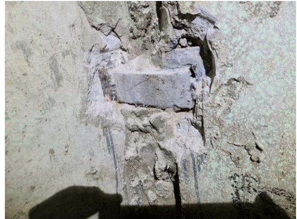
5.2.att. Atsegumā konstatētas ieliekamās detaļas 80x80x8 mm, kas piemetinātas pie d12 izlaidumiem. Paneļu ieliekamo detaļu savienojums ierīkots piemetinot loksni 60x120x8 mm.
