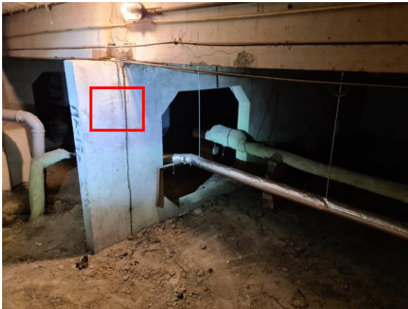
2.1.att. Jumta nesošās konstrukcijas panelis PK-17. Rudens iela 4, Rīga. Pēc Projekta betona marka M200 (C12/15).
