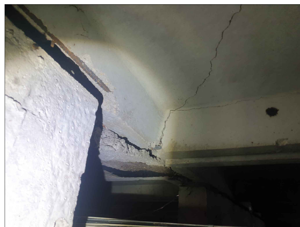
2.att. Bojātās jumta plātnes riba savienojuma attēls
