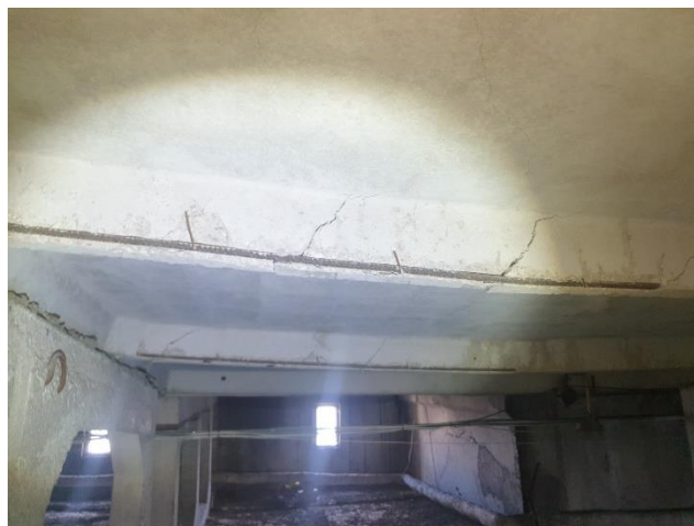
67.att. Izliekusies un saplaisājusi jumta plātnes riba
