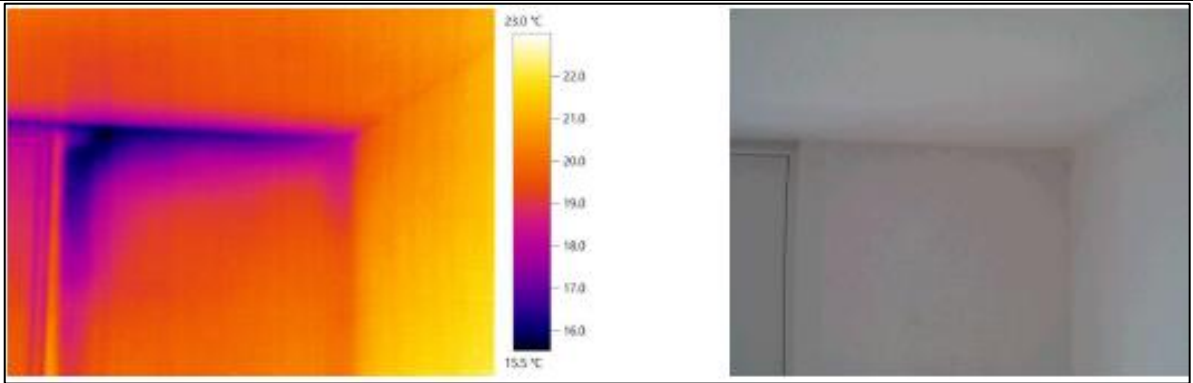
1.3.4.20. attēls. Kāpņu telpa 5. stāva līmenī.
