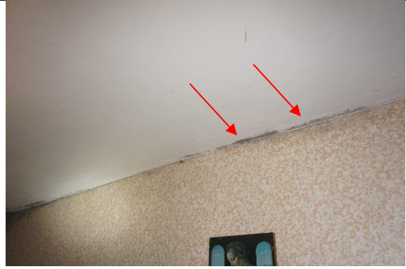
1.3.4.24. attēls. Piektā stāva stūra dzīvoklis.
