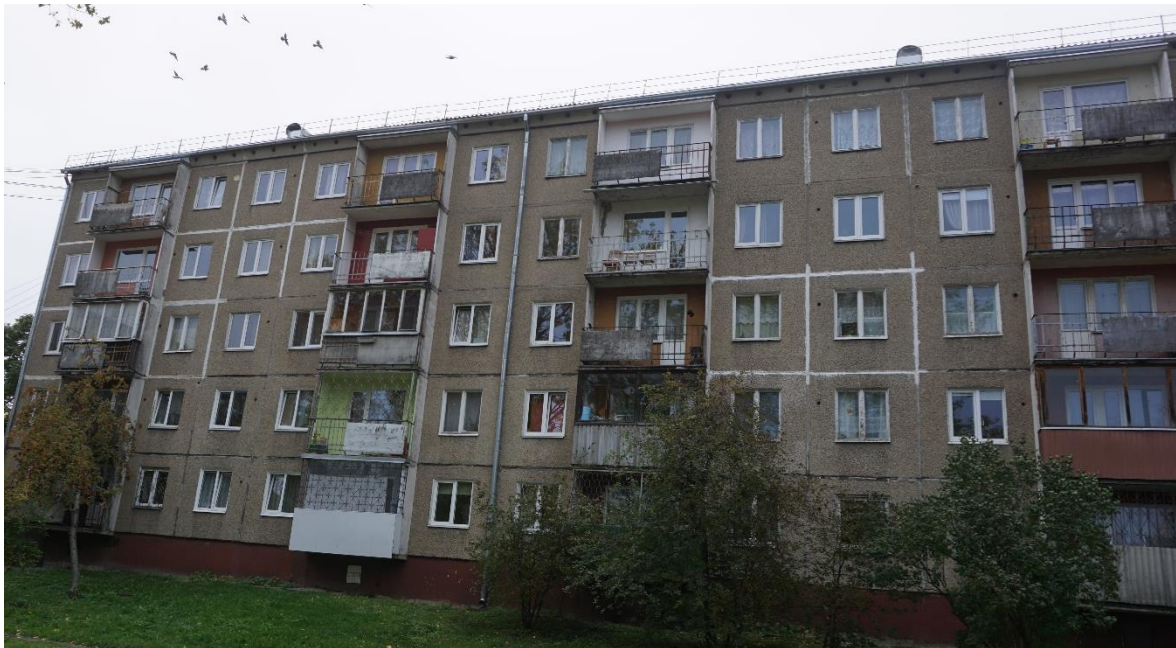
1.2.2.1. attēls. Vecākā tipa ēku fasāde.
