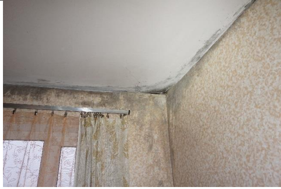
1.3.4.23. attēls. Piektā stāva stūra dzīvoklis.
