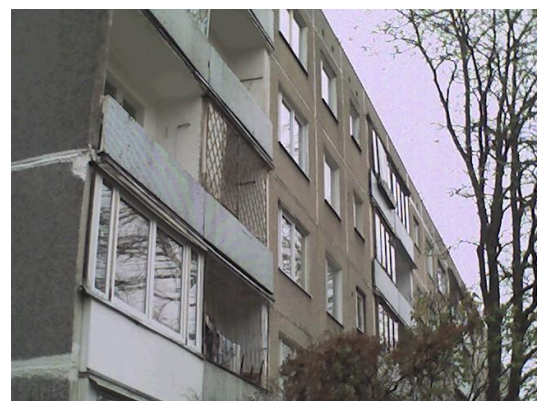
11.attēls. Ēkas fasāde, ārsienas/balkona termiskais tilts
