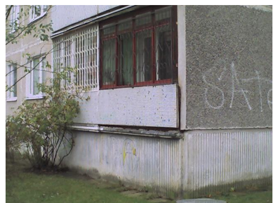
11.attēls. Ēkas fasāde, ārsienas/balkona termiskais tilts
