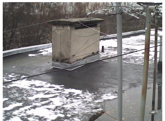
16.attēls. Pārseguma/ārsiena termiskais tilts
