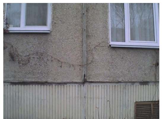
15.attēls. Paaugstināta virsmas temperatūra paneļu savienojuma vietās un loga rāmja/stiklojuma termiskais tilts
