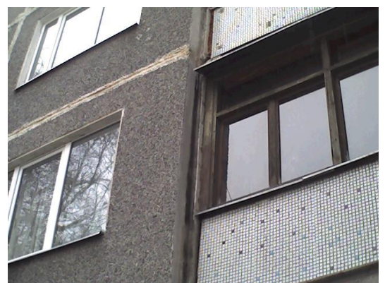
12.attēls. Termiskais tilts, paaugstināta virsmas temperatūra loga rāmja/stiklojuma savienojuma vietā
