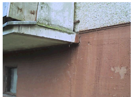
10.attēls. Paaugstināta virsmas temperatūra balkona/ārsienas mezglā
