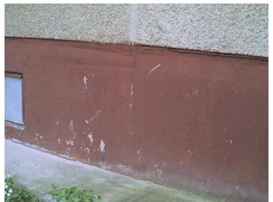
4.attēls. Virsmas temperatūras paaugstināšanās cokola paneļu šuvju vietā
