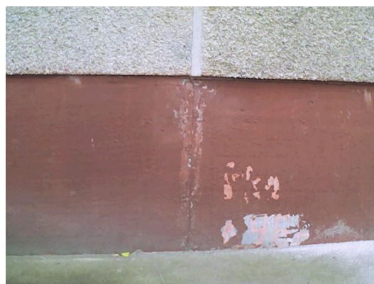
2.attēls. Virsmas temperatūras paaugstināšanās cokola paneļu šuvju vietā
