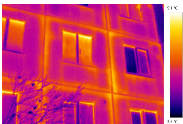
12.attēls. Lokāla temperatūras paaugstināšanās paneļu šuvju vietās
