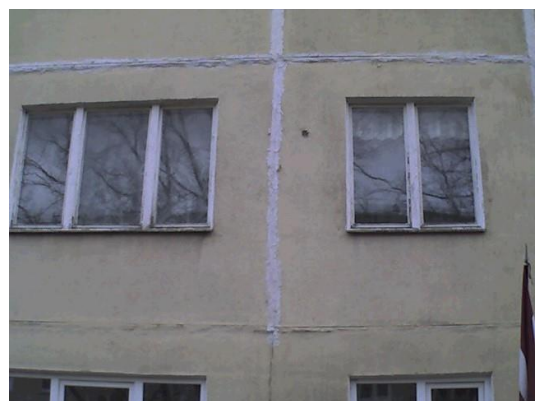
5.attēls. Lokāla temperatūras paaugstināšanās paneļu šuvju vietās
