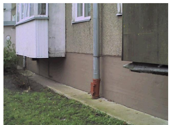
11.attēls. Paaugstināta virsmas temperatūra cokola/ārsiena mezglā
