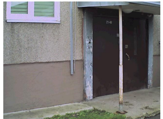
17.attēls. leejas bloks, termiskais tilts paneļu savienojuma vietā
