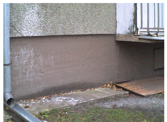
6.attēls. Siltuma zudumi caur cokola paneļu šuvēm
