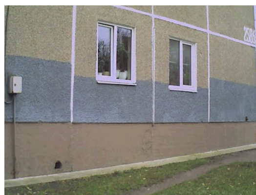
2.attēls. Ēkas austrumu fasāde, siltuma sudumi caur paneļu savienojuma vietām, logu rāmjiem
