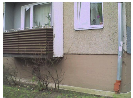
11.attēls. Paaugstināta virsmas temperatūra cokola/ārsiena mezglā
