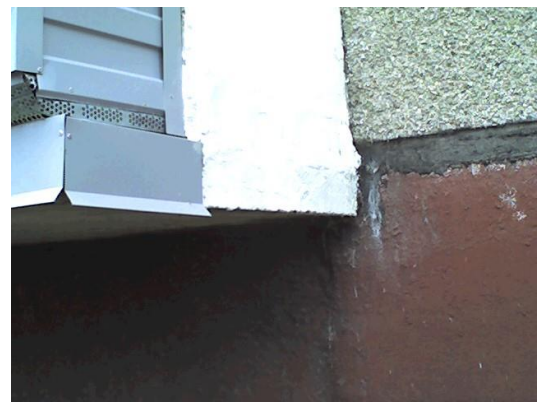
7.attēls. Siltuma zudumi no dzīvokļa uz kāpņu telpu
