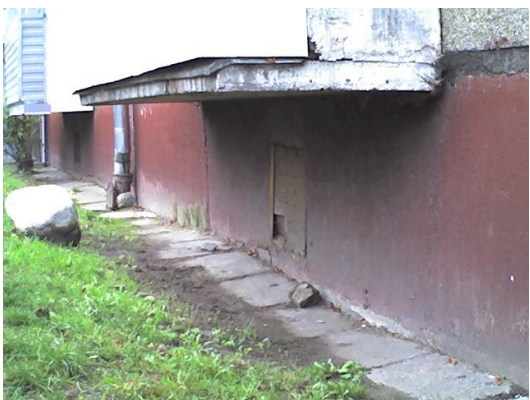
3.attēls. Ēkas cokols, paaugstināta virsmas temperatūra cokola paneļu savienojuma vietās
