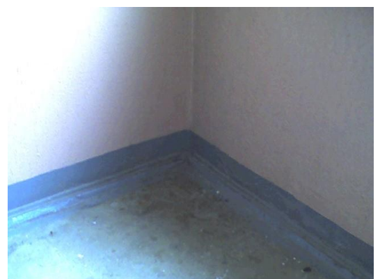
6.attēls. Termiskais tilts pārseguma/ārsienas mezglā
