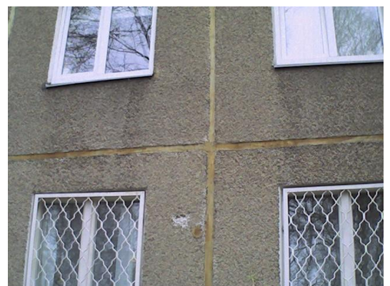
14.attēls. Siltuma zudumi caur logiem un ārsienu paneļu savienojuma vietām
