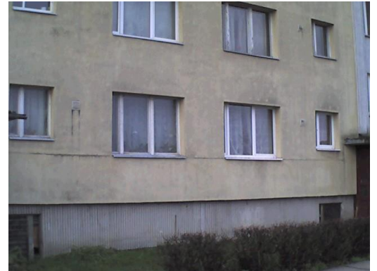
1. att. Ēkas fasāde (siltināta) un cokols (nesiltināts)
