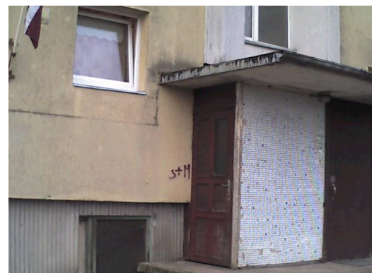
2.att. Ēkas ieejas mezgls un ārsiena (termiskais tilts)
