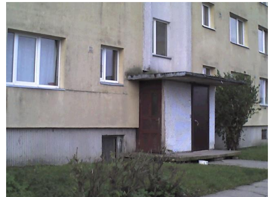
4.att. Ēkas ārsiena (termiskie tilti dībeļu vietās siltumizolācijā)
