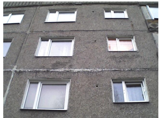
7.attēls. Ēkas dienvidu fasāde, siltuma zudumi caur logiem.
