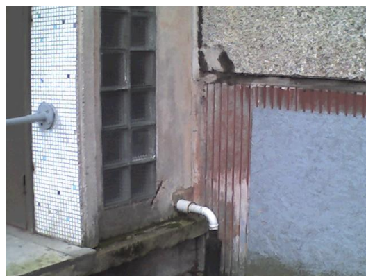
2.attēls. Termiskais tilts konstrukciju savienojuma vietā
