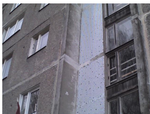
14.attēls. Termiskais tilts ēkas stūros, siltuma zudumi caur kāpņu telpas logiem
